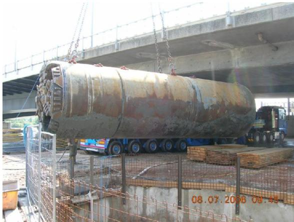
**Abb. 27: NW2, Vortriebsmaschine.**
