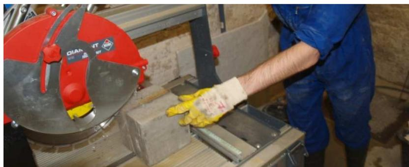
Abbildung 7.11: Schneiden der Starterkerbe
