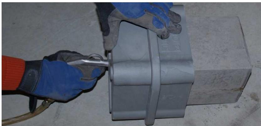
Abbildung 7.7: Ausschalen mittels Pressluft
