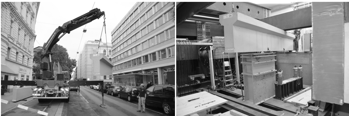
Abbildung 3.7: Anlieferung (li.) und Einbau (re.) der Versuchsträger
