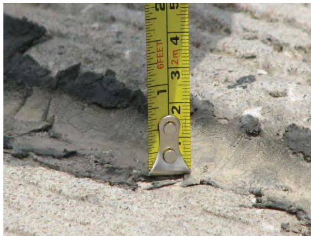
Abbildung 3.26: Höhenversatz aufgrund Steifigkeitssprung [37]
