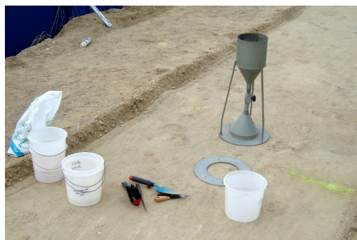
Abbildung 3.26: Durchführung des Sandersatzverfahrens
