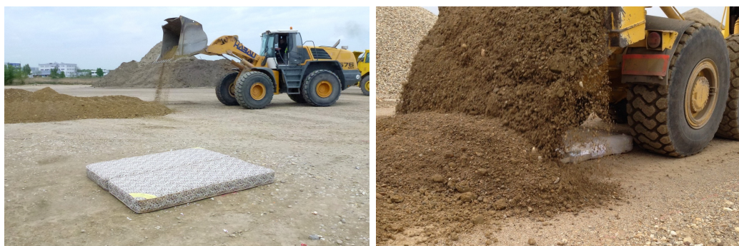
Abbildung 3.7: Schüttung der Schwachstelle in der ersten und zweiten Lage
