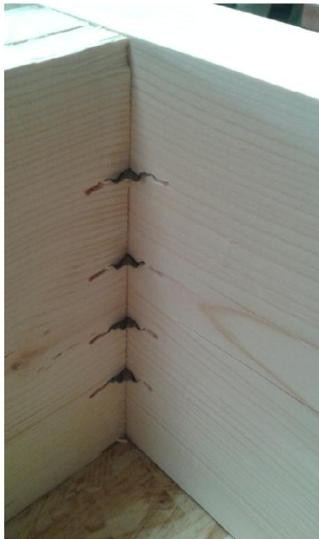
Abbildung 2-15: Verbindung der Rippen durch Wellennägel
