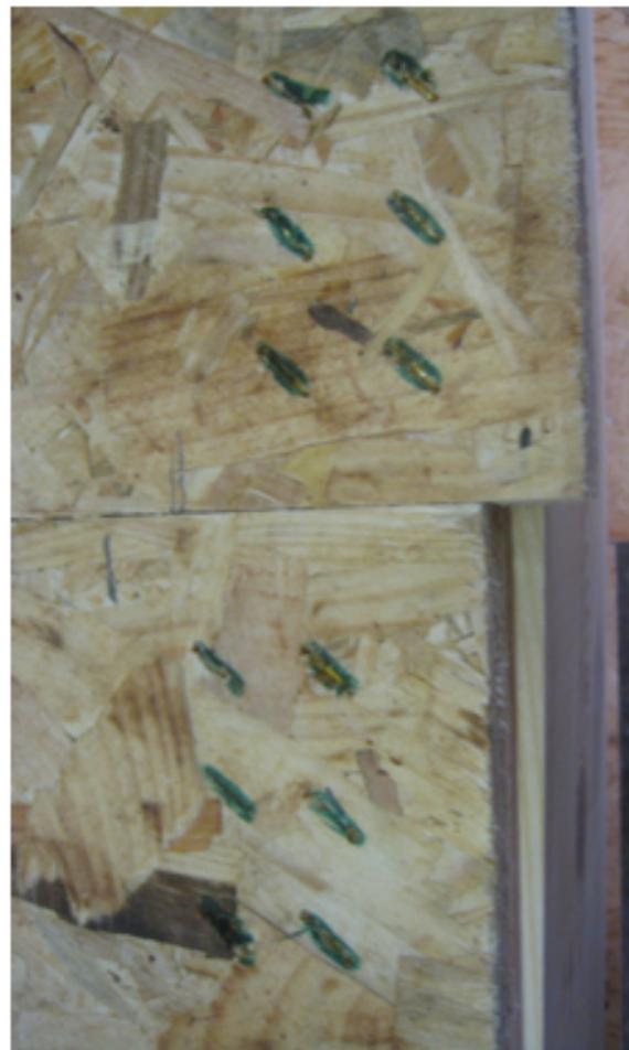
Abbildung 2-27: Konzentrierte Klammerung am freiem
