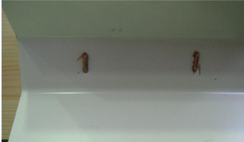
Abbildung 4-29: Trapezprofil mit Klammerbefestigung
