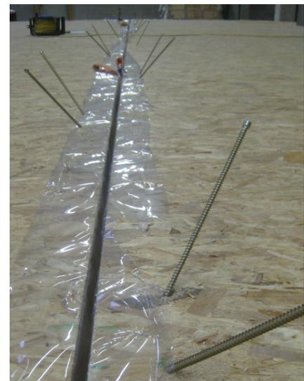
Abbildung 2-24 a) und b): Fugenverschraubung mit Vollgewindekreuzen<sup>44</sup>
