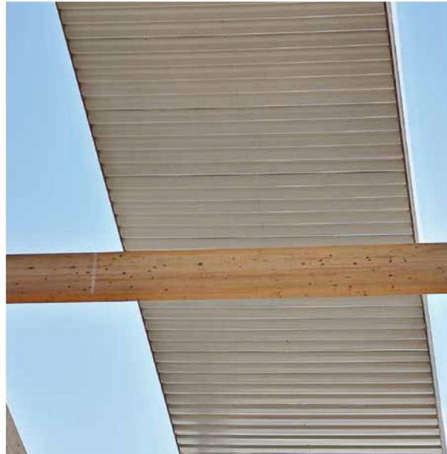
Abbildung 4-24: Dachelement der Firma *Rubner* mit Trapezblechuntersicht
