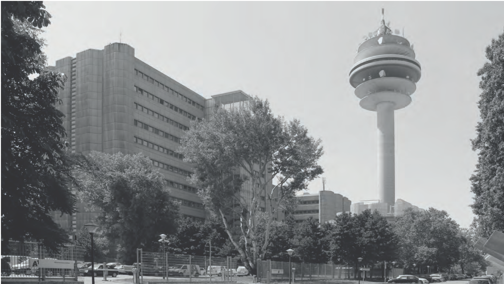
Abb.12. Telekomzentrum mit Sendeturm
