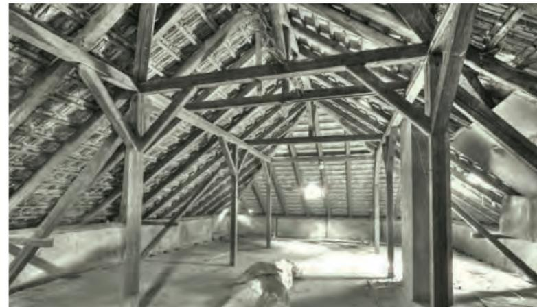
Abb. 50: Beispiel für einen abgestrebten Pfettendachstuhl
