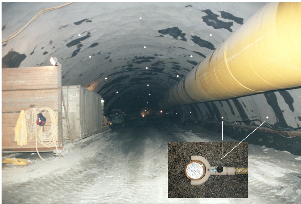
Abb.5: Anordnung von Messpunkten und Messquerschnitten im Tunnel
