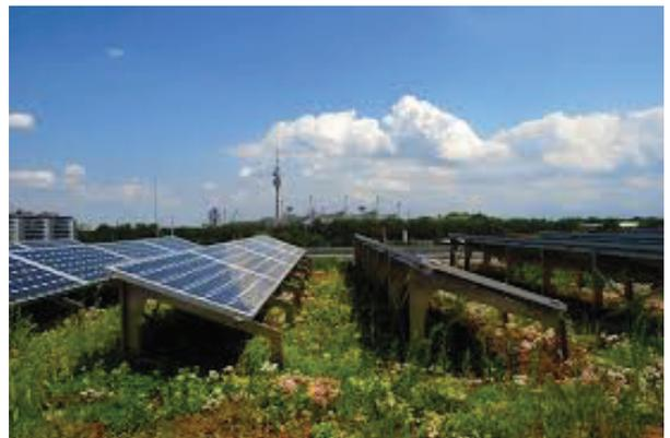
Abb. 48: Die PV-Module werden auf einem Gerüst auf dem begrünten Dach montiert. Quelle: ZEBE 2012
