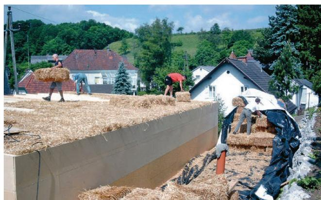
Abb. 23: Passivhaus mit Strohdämmung in Steyr. Quelle: ZACHL 2014
