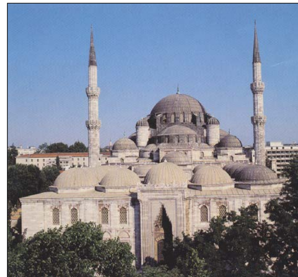
Abb.56: Şehzade Moschee, Nordfassade
