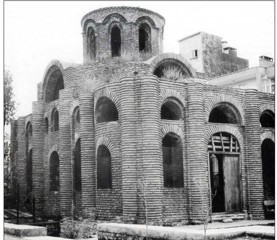
Abb.80: Myrelaion Kirche - Bodrum Moschee, Ziegelmauerwerk der Fassade
