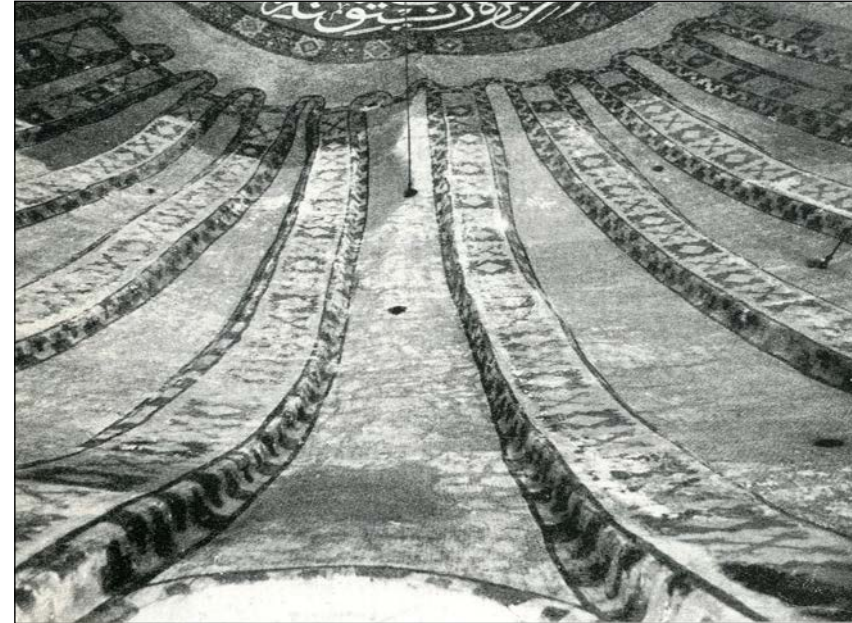
Abb.82: Hagia Sophia, Kuppelrippen: links aus dem 14. Jh. und rechts die Originalrippen aus dem 6. Jh.
