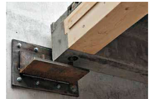
Bild 16, Einhängen der Deckenelemente
