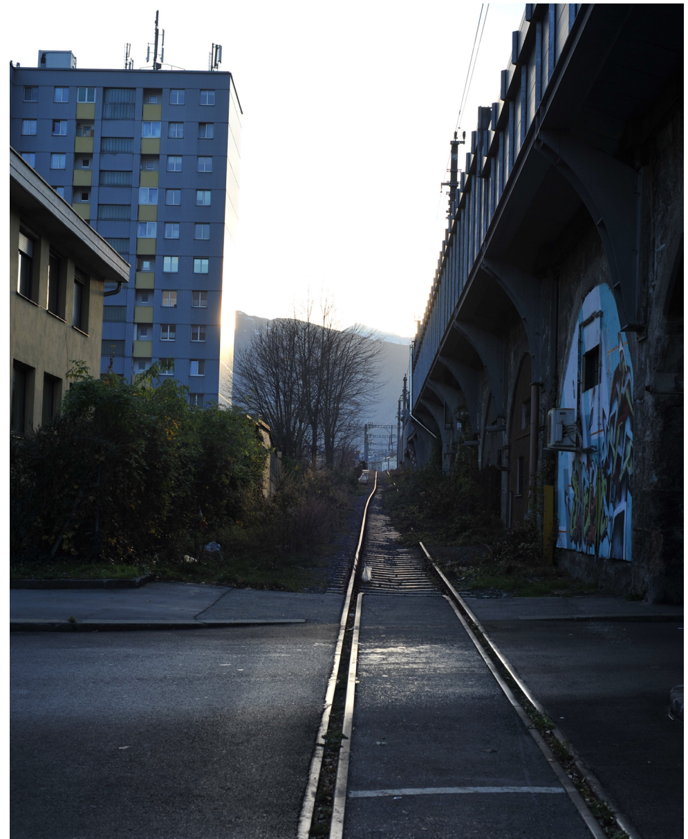
Bild 22, Blick der alten unbenutzten Bahngleise entlang der Viaduktbögen
