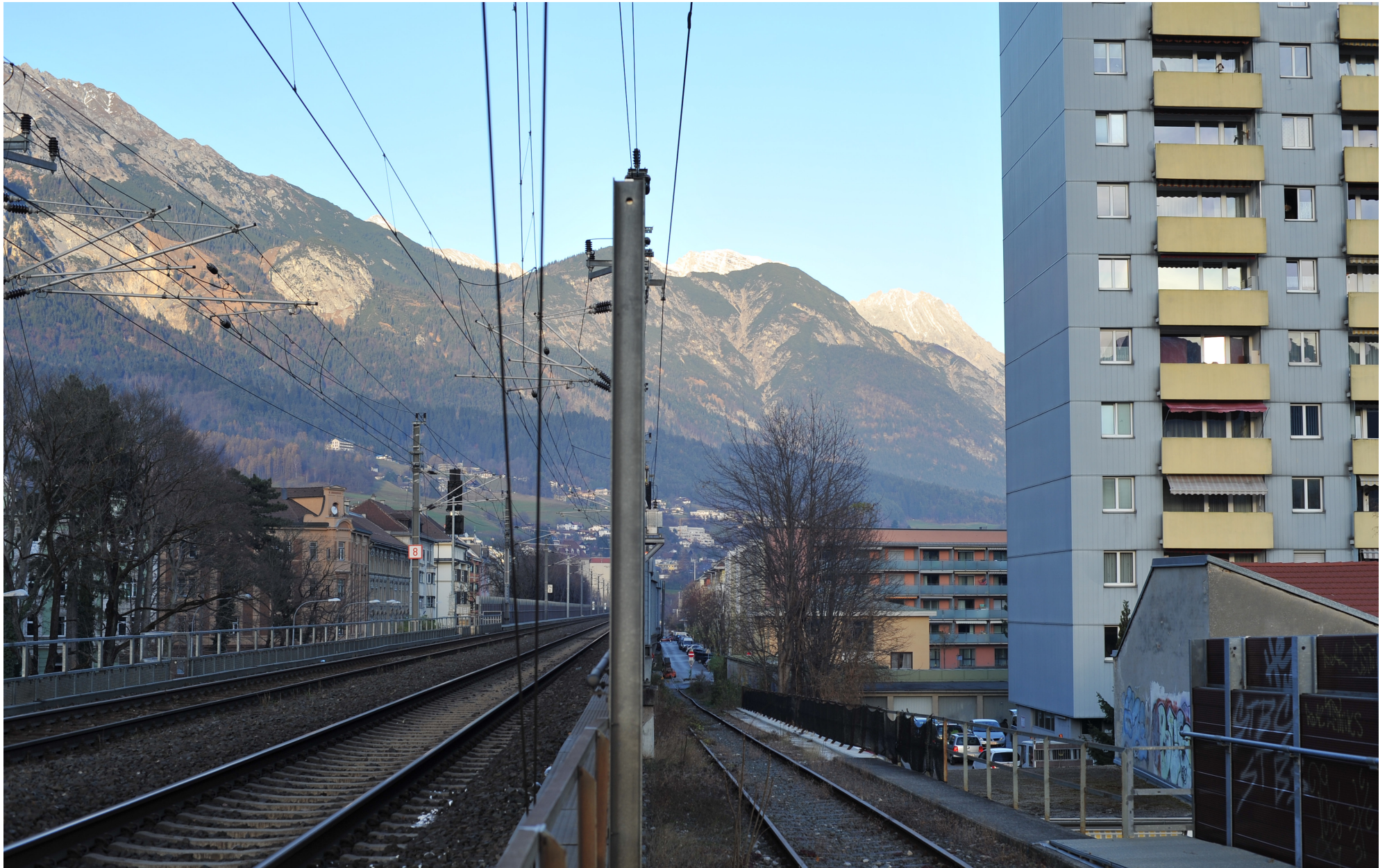
Bild 20, Der Blick von der Bahntrasse Richtung Osten
