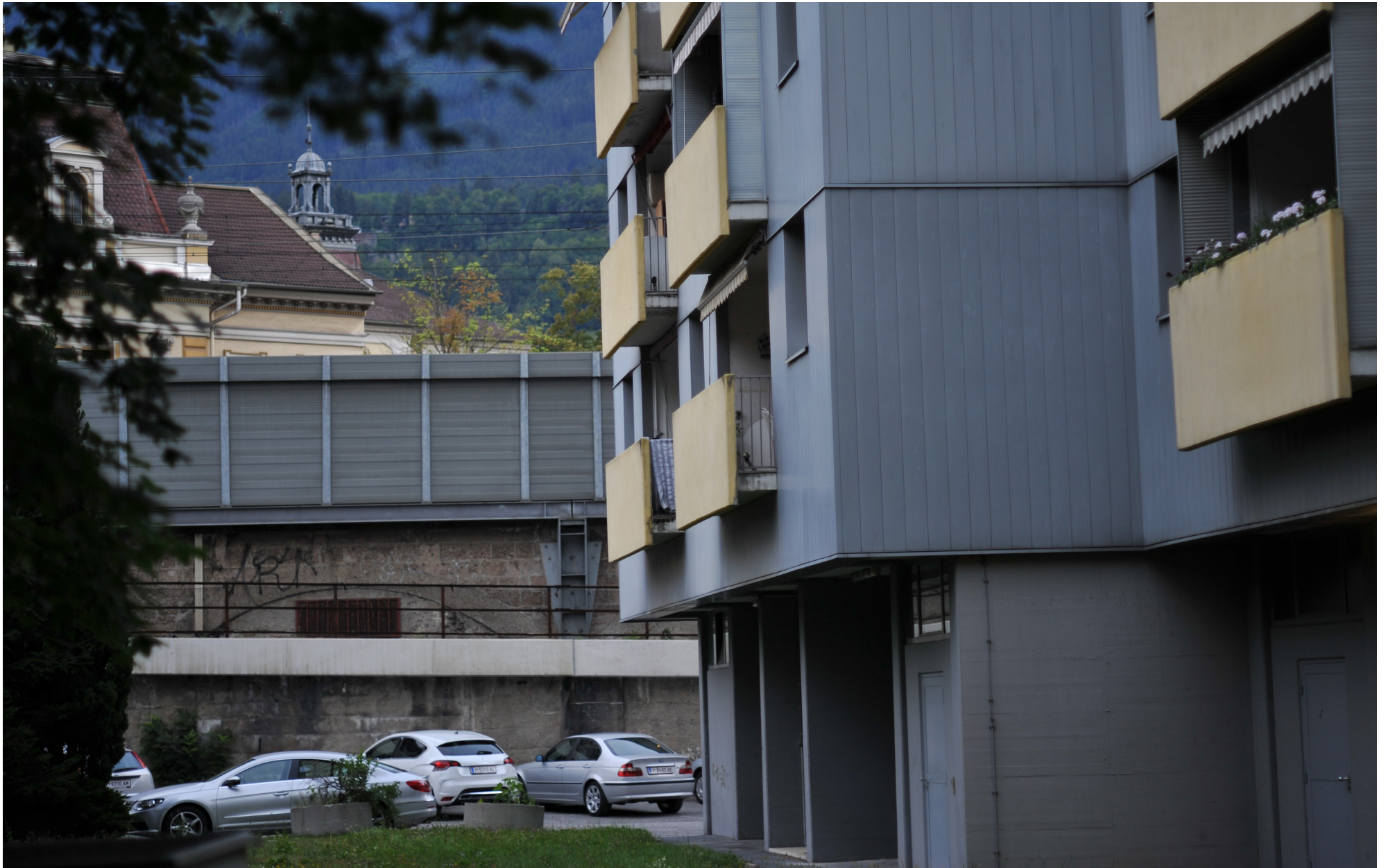
Bild 21, Ostseitiger Hof, Blick Richtung Bahntrasse
