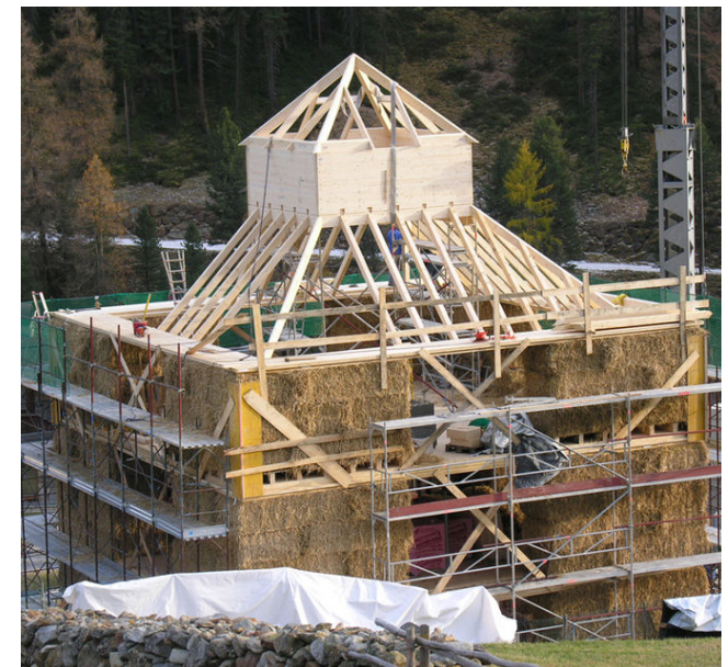
Bild 7, Eindeckung des Daches mit Strohdämmung
