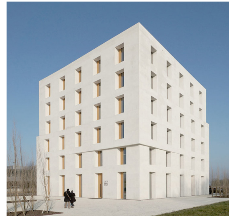
Bild 3, Bürogebäude in Lauterach
