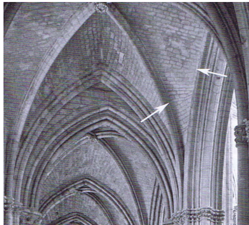
Abbildung 2.13: Erweitertes Kreuzgewölbe mit Aufwölbung der Kappenteilflächen aus [23]
