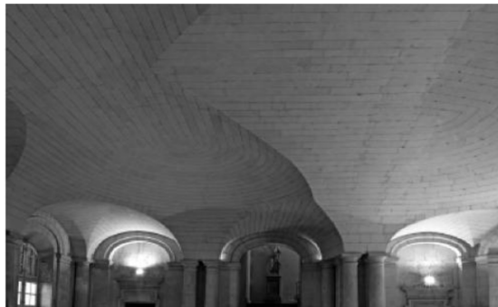
Abbildung 2.3: Untersicht eines Werksteingewölbes aus [63]
