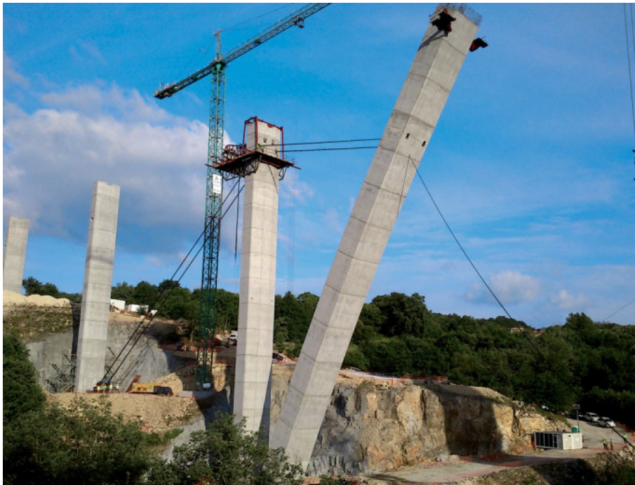
Abbildung 1.9: Bogenklappverfahren, Foto: VSL Heavy Lifting, Schweiz.
