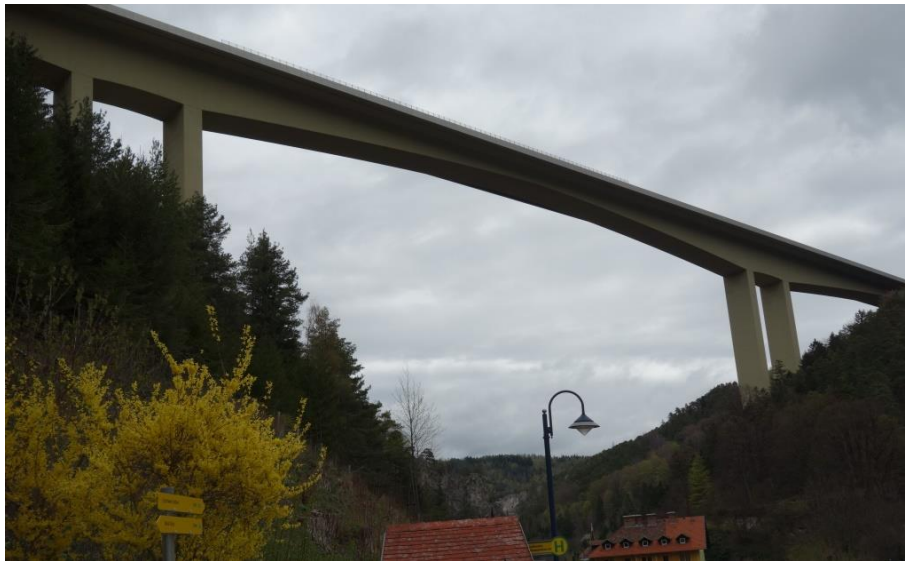
Abbildung 1.7: Ansicht vom Talgrund der Talbrücke Schottwien.
