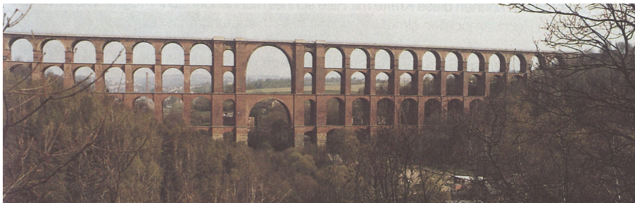
Abbildung 1.2: Ansicht der Göltzschtalbrücke [Pfeifer und Mölter, 2008].
