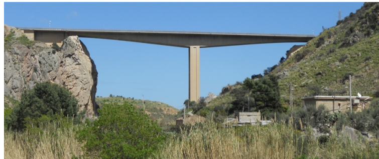
Abbildung 3.1: Ansicht der San Leonardo Talbrücke in Sizilien.
