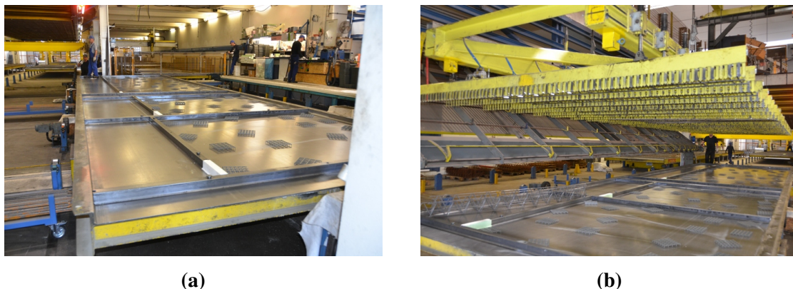
Abbildung 3.6: Herstellung von Doppelwänden: (a) Schaltisch mit Abschalelementen und Abstandhaltern; (b) Bewehren.
