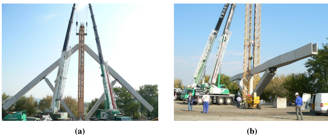
Abbildung 3.27: Prototyp Brückenklappverfahren [Gmainer, 2011] (a) Frontalansicht; (b) Hilfspfeiler bestehend aus zwei Kranentürmen.
