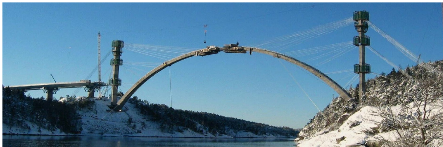
Abbildung 1.8: Betonbogen im Freivorbau [Fischer, 2014].
