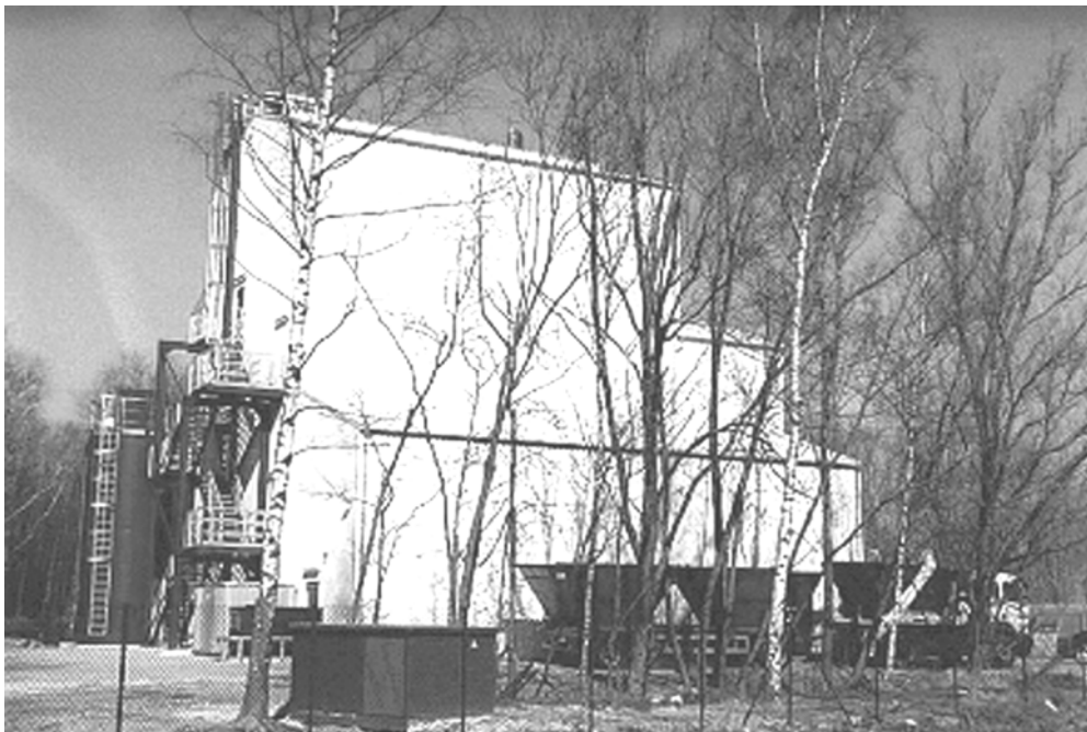
Abbildung 4: Außenansicht der Klärschlammbehandlungsanlage Sande
