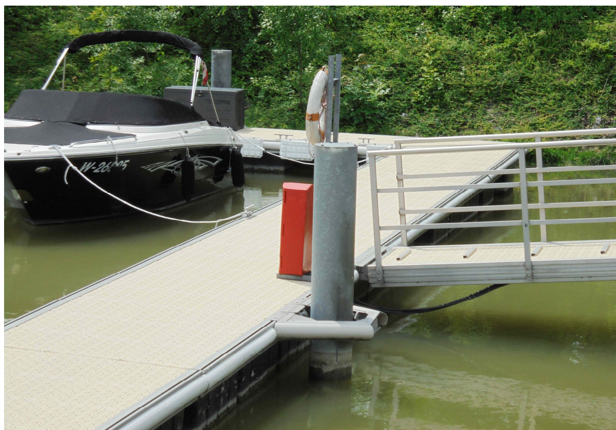
Abbildung 6.4: Führungsdalben für einen schwimmenden Anlegesteg im Yachthafen „Marina Wien“ 229
