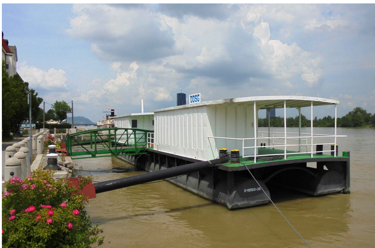
Abbildung 6.3: Befestigung eines schwimmenden Anlegesteges am Ufer 226
