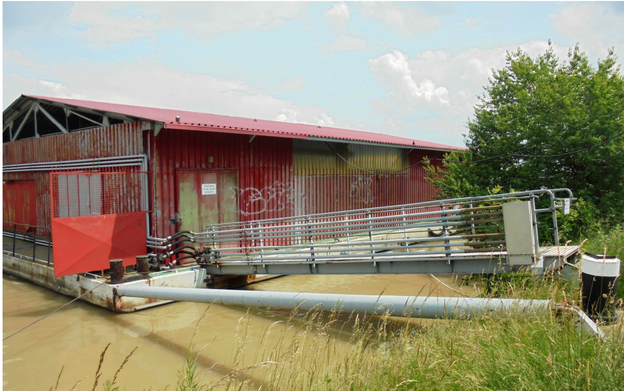
Abbildung 6.7: Stützpunkt der Berufsfeuerwehr Wien mit Bootstankstelle; Lage: rechtes Donauufer –Stromkilometer ca. 1.927,700 263
