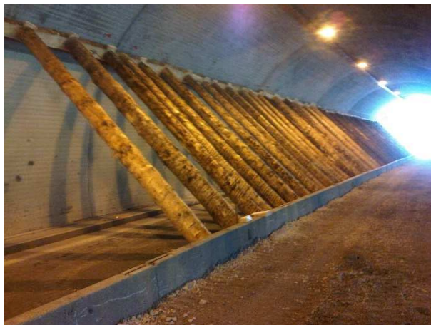
Abbildung 4.2: Provisorische Aussteifung mittels Holzstämmen 106
