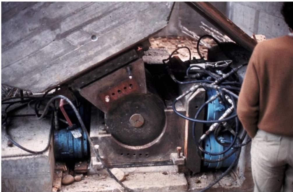
Abbildung 2.4.1.2: Gelenk der Argentobelbrücke
