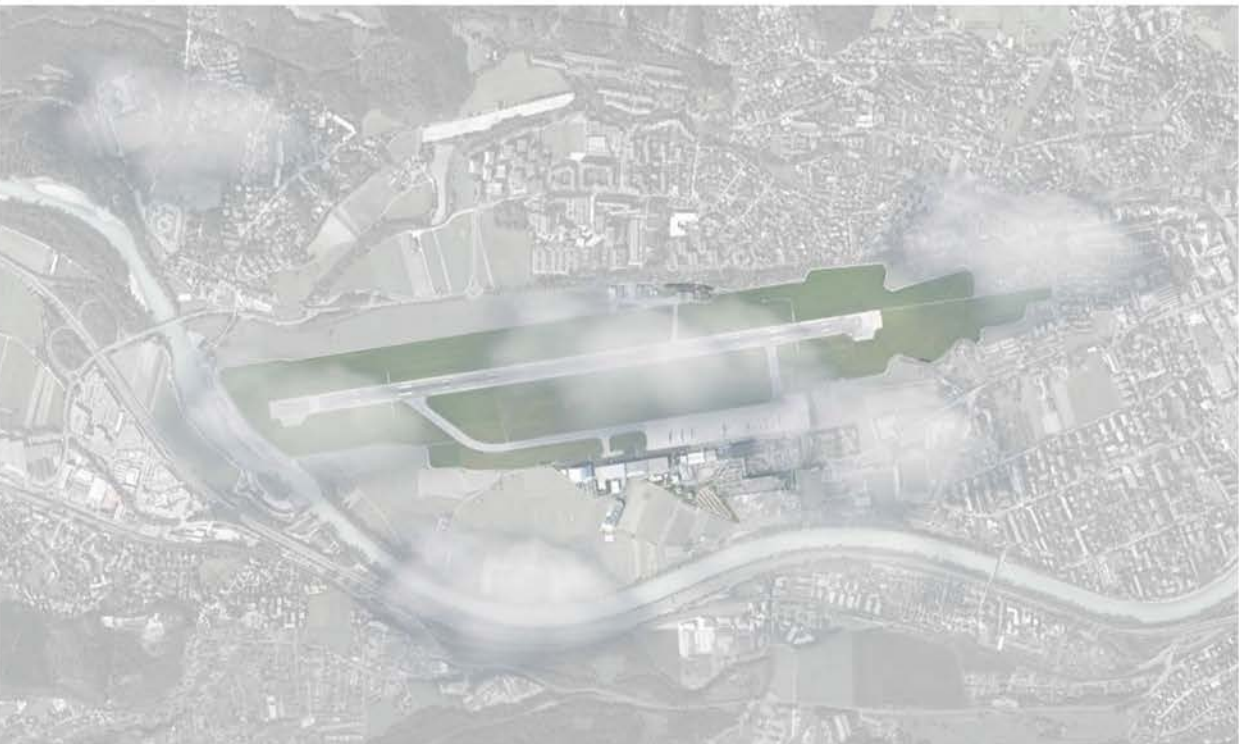
Abb.147 Vorher Flughafen Innsbruck
