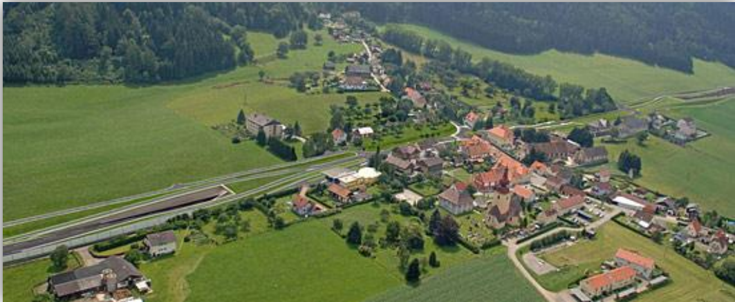
Abbildung 22: Die Unterführung bei St. Georgen ob Judenburg, nach Realisierung des S36-Vorhabens. Quelle: http://www.pros36.at/upload/ban_pic/unterflurtrasse_3.jpg
