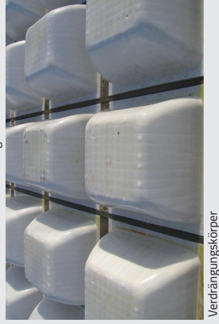
Kassettendecke vor Ortbetonverguss
