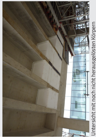
Schalung für Rippendecken
