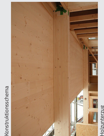
Montage einer Decke mit Öffnungen
