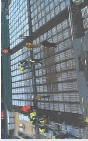
Kassettendecke vor Ortbetonverguss
