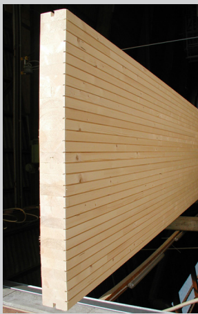
Montage einer Deckenplatte
