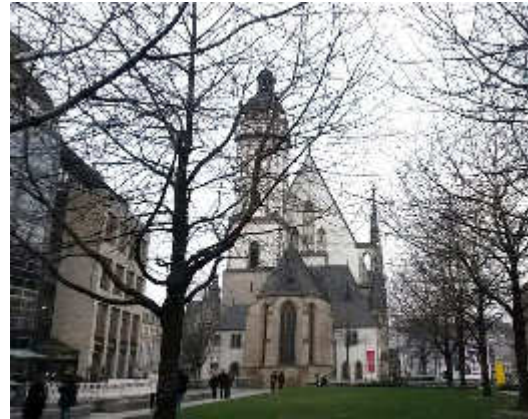
Abbildung 40: Thomaskirche Leipzig Quelle: eigenes Foto
