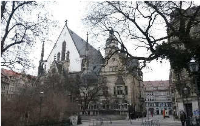
Abbildung 39: Thomaskirche Leipzig Quelle: eigenes Foto
