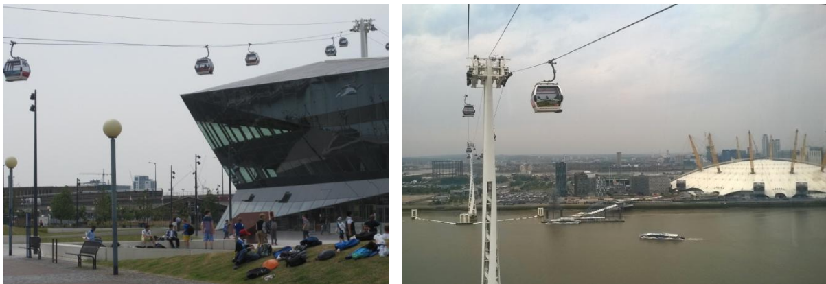
Abbildung 3-1: Emirates Air Line; eigene Fotos
