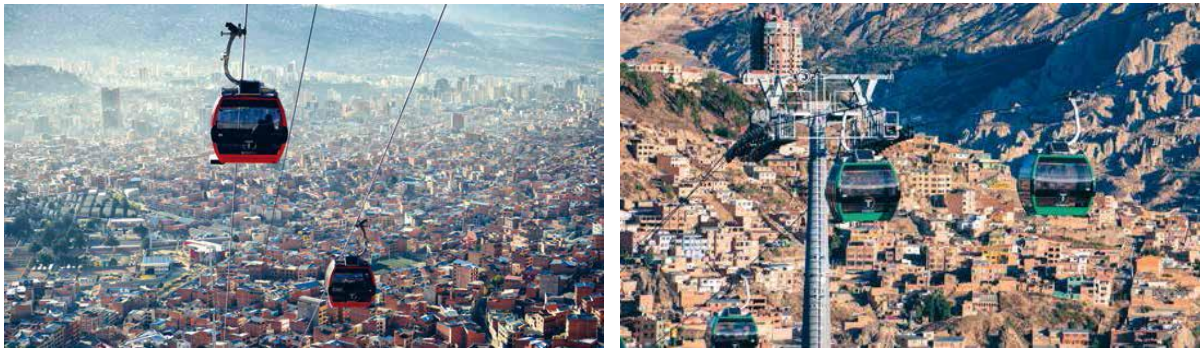
Abbildung 3-6: Línea Roja und Línea Verde in La Paz / El Alto. Quelle: Doppelmayr
