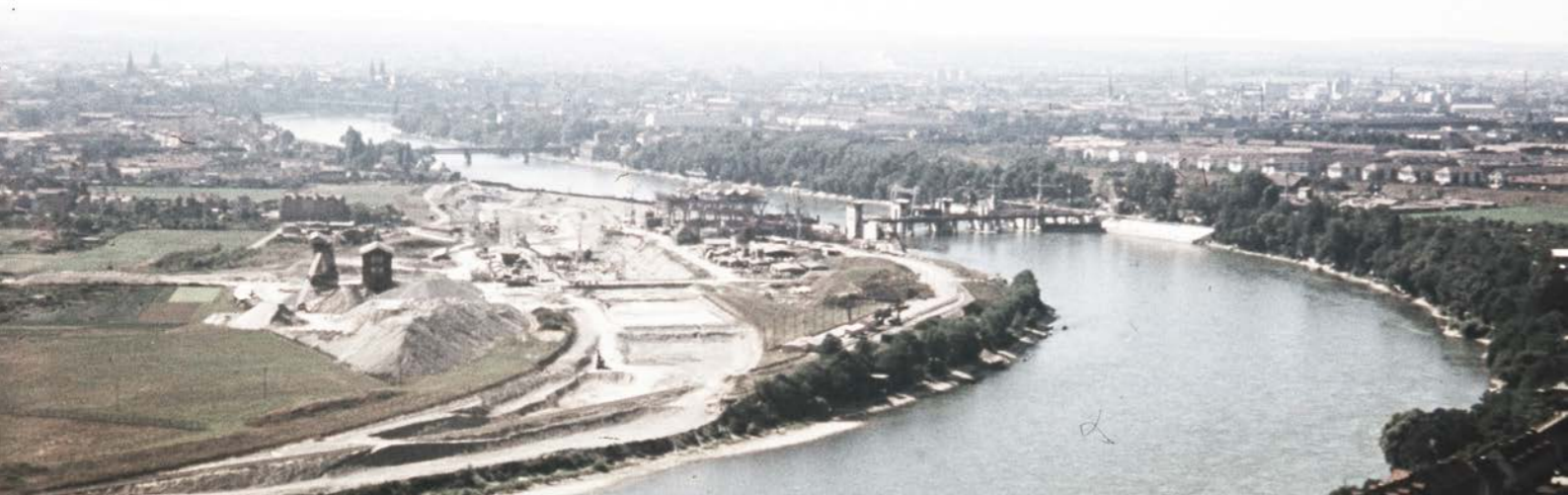
Abb. 14 - Bau der Kraftwerkinsel
