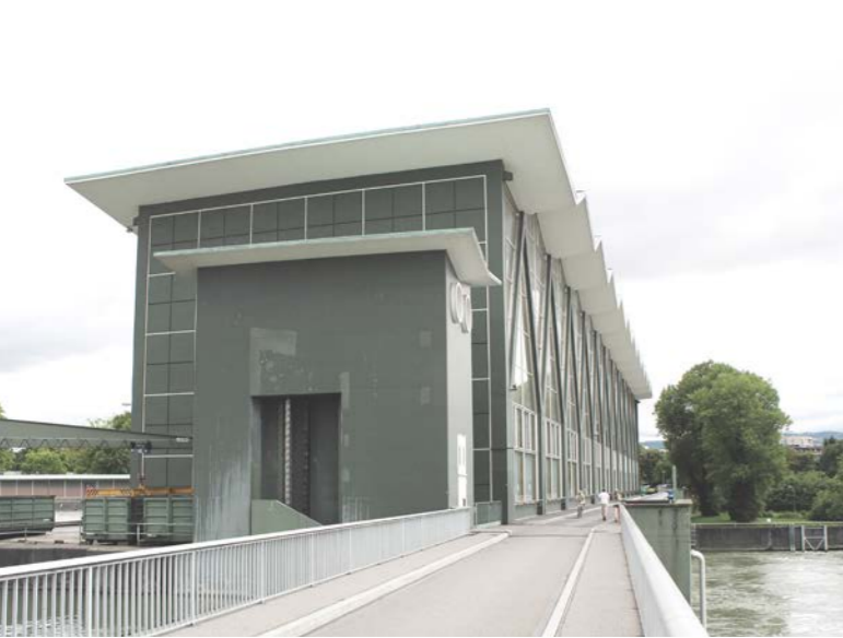
Abb. 22 _ Holzapfelsteg mit Blick auf das Maschinenhaus
