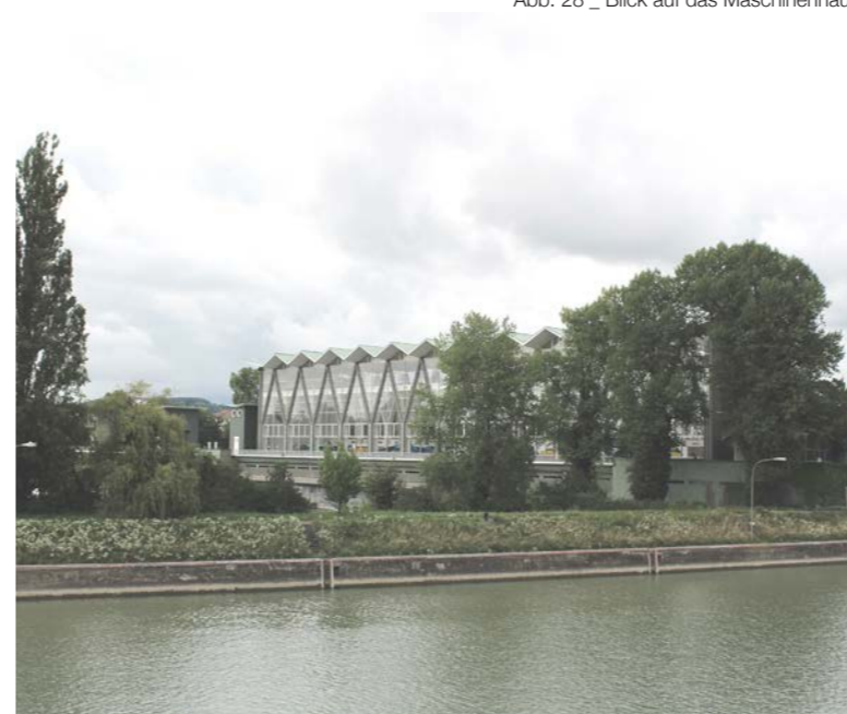
Abb. 28 _ Blick auf das Maschinenhaus
