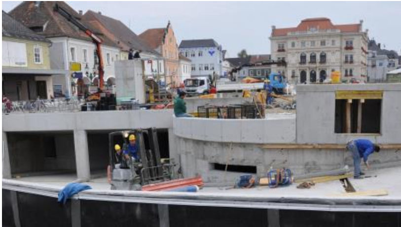
Abbildung 4.6.2-1: Stadtgemeinde Tulln – Hauptplatz – Errichtung Tiefgarage 91
