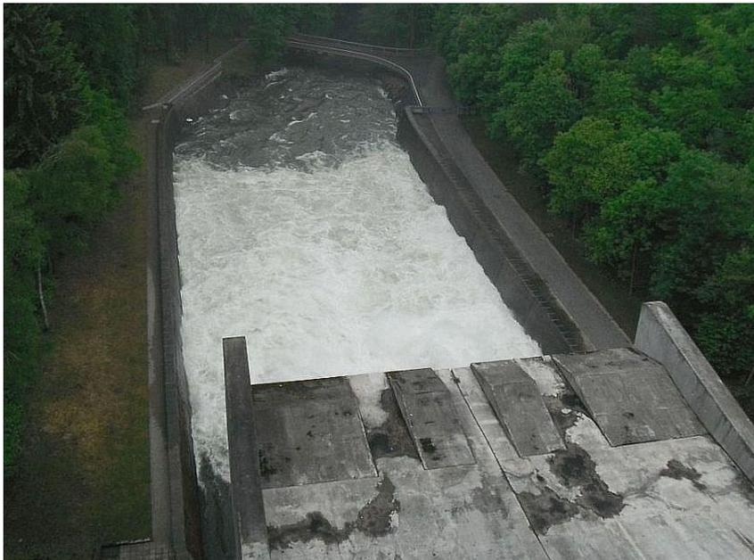
Abbildung 22: Tosbecken mit Sprungschanze der Talsperre Pöhl, Sachsen [20]
