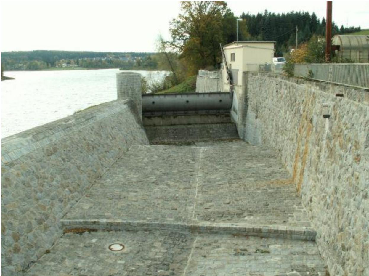
Abbildung 28: Oberes Tosbecken mit festen Überfall und Wehrklappe, Talsperre Malter, Sachsen [20]
