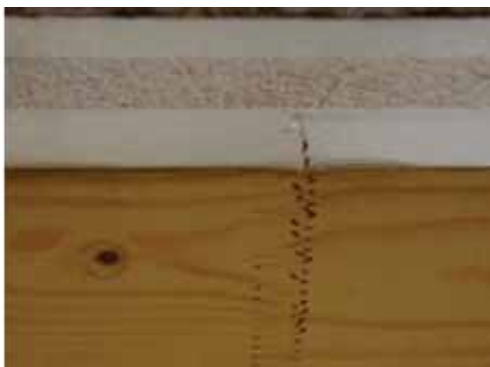
Abbildung 2.43.: Versagen der Keilzinkung unter der Lasteinleitung F_A
