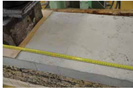
Abbildung 2.52.: Betonzugriss bei F_B (150 cm vom Trägerende)
