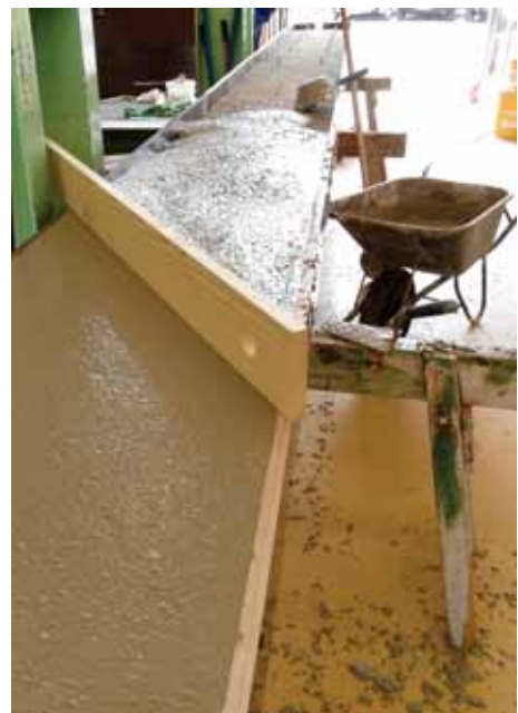
Abbildung 2.32.: Einbringen und Abziehen des Betons (SVB)
