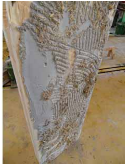
Abbildung 2.46.: Oberfläche der BSP-Platte am Auflager A
