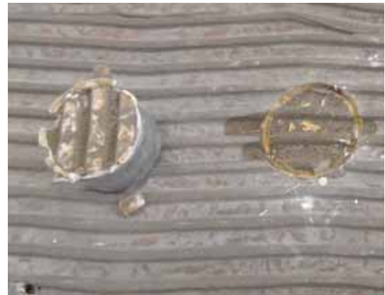
Abbildung 2.16.: Bruchfläche SikaTop®-109 ElastoCem
