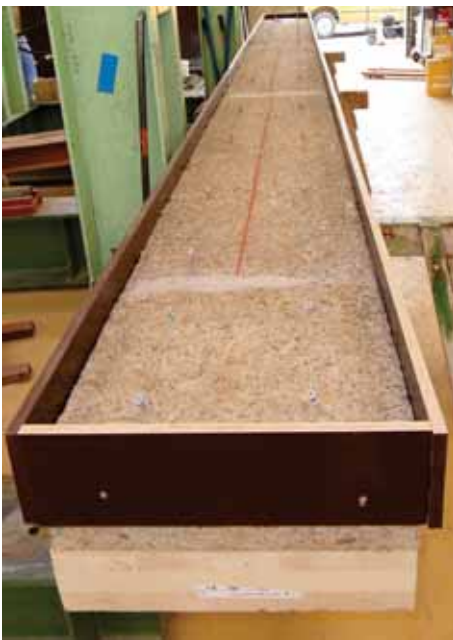
Abbildung 2.31.: Befestigung der Schalung am Holzleichtbeton (Velox-Platten)
