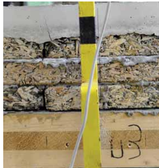
Abbildung 2.73.: Risse in der Beton- und Veloxschicht, nach Entlastung
