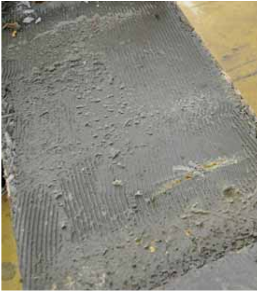
Abbildung 2.53.: Oberfläche der obersten Klebeschicht
