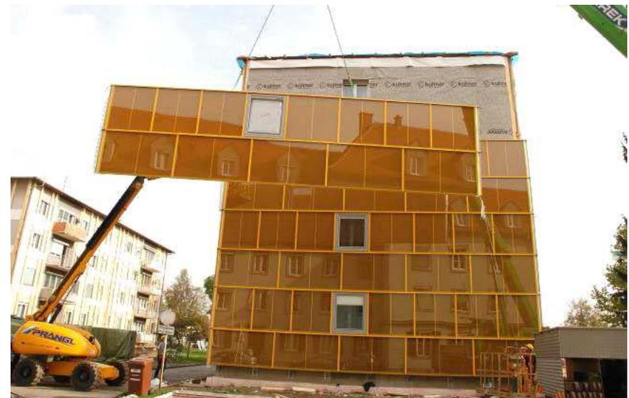
Abb. 87: Versetzen der Fassadenelemente
