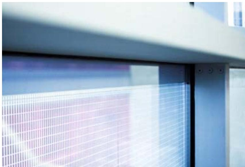
Abb. 90: Dünnschicht-PV integriert in Fassade
