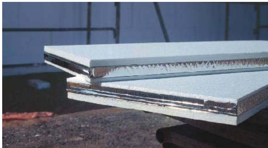
Abb. 78: Vakuu-Isolations-Paneelen mit Polystyroldeckschicht
