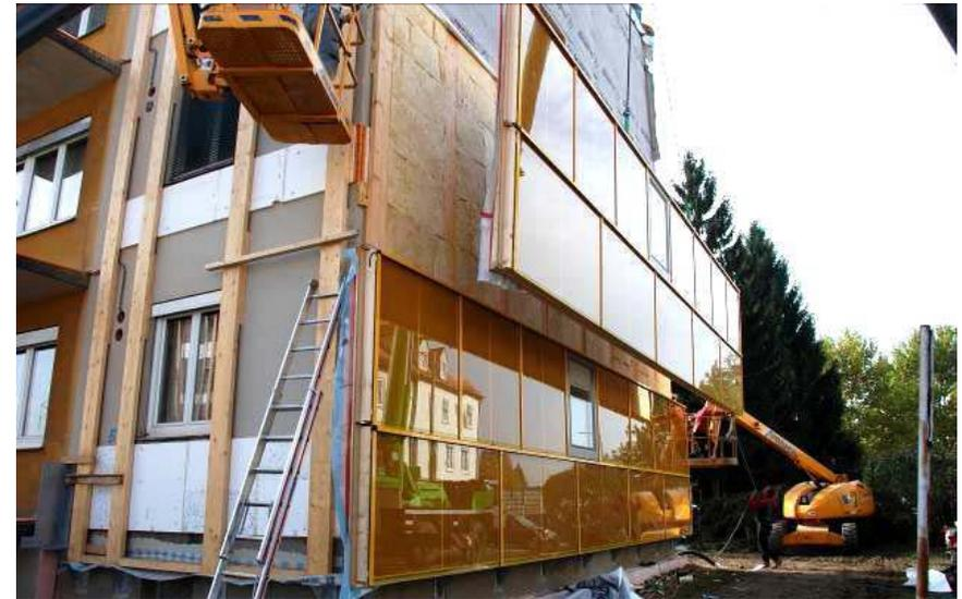
Abb. 86: Anbringen der Fassadenelemente
