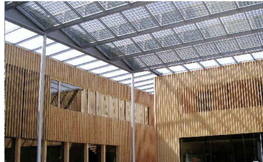
Abb. 89: Horizontale Verglasung mit integrierten Photovoltaikzellen
