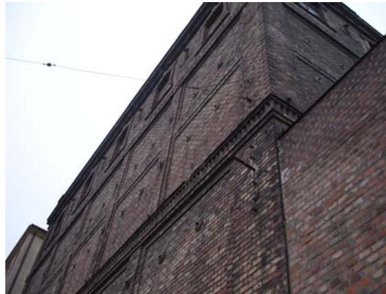
Abb. 31: Eisenschließen an der Fassade
