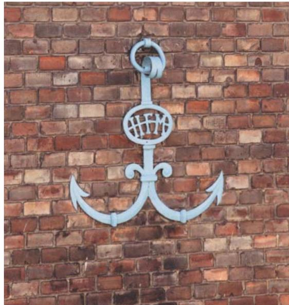
Abb. 32: Anker an der Fassade
