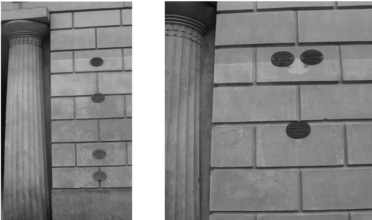
Abb. 3: Willkürlich veränderte Hochwassermarken am Fliederhof im Schloss Pillnitz bei Dresden. Die helle Linie auf beiden Bildern zeigt den Höchstwasserstand im August 2002 an, die dunkle Marke links (oben) den historischen Hochwasserstand vom März 1845. Auf der rechten Seite sind die Hochwassermarke von 1845 nach oben gesetzt und die neue Hochwassermarke von 2002 oberhalb des Maximalwasserstandes angebracht (Fotos: Grünewald, 2003 und 2004).
