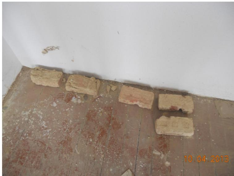
Abb. 14: herausgelöste Mauerziegel
