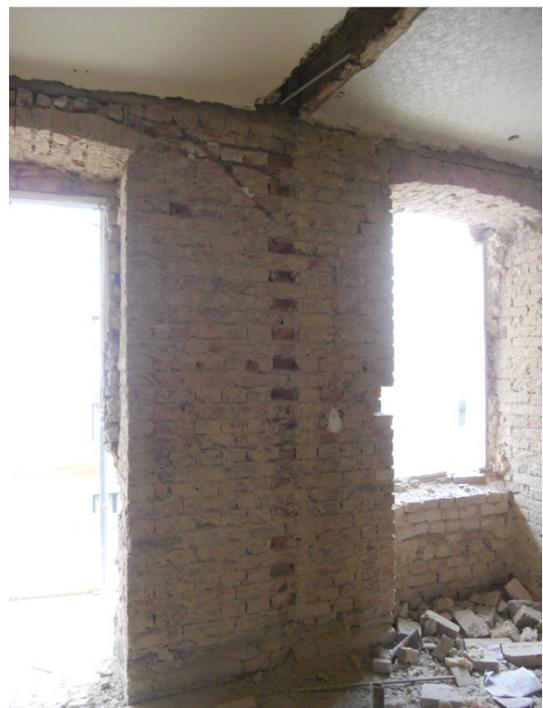
Abb. 27: Verzahnung der Zwischenwände
