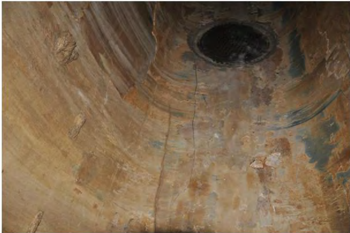
Abbildung 2.8: Zugrisse in der Sohle des Stollens (Poisel, 2010).
