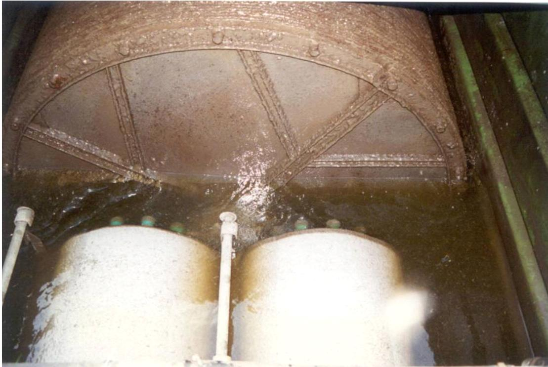
Abbildung 10-7: Scheibentauchkörper mit Tuchfilter.
