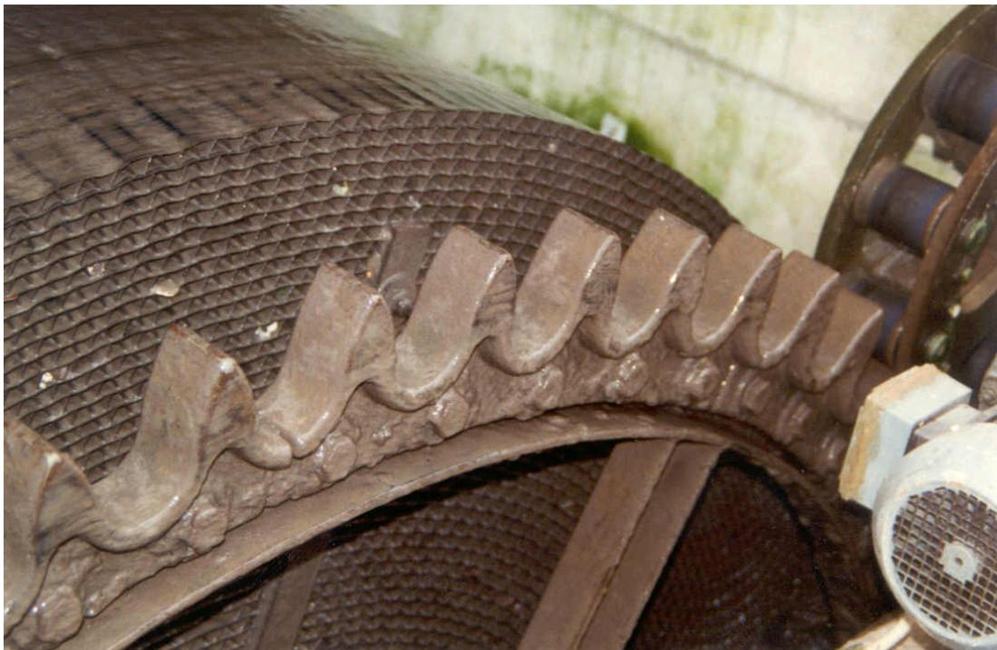
Abbildung 10-8: Wickeltauchkörper mit Antrieb.
