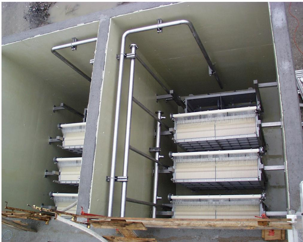
Abbildung 11-48: Plattenmembran, Quelle: SANDOZ Ges.m.b.H.
