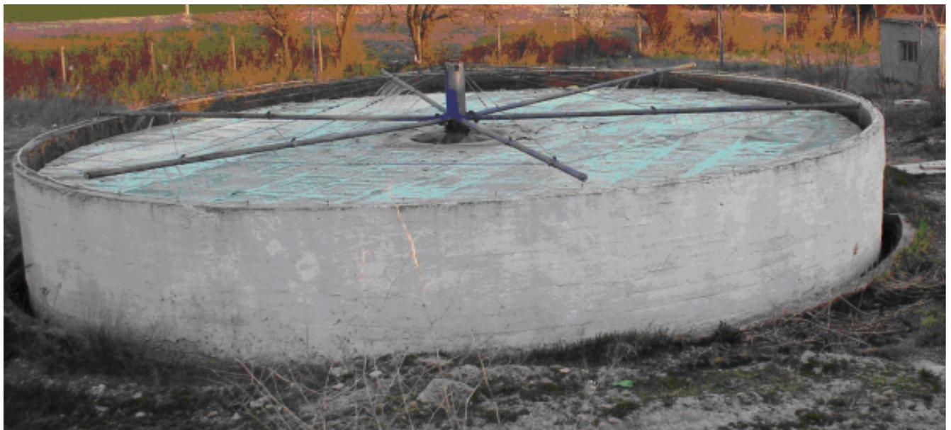
Abbildung 10-3: Tropfkörper mit Drehsprenger.
