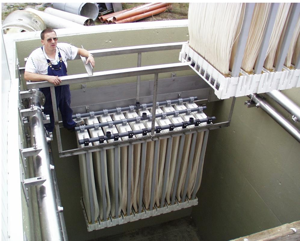
Abbildung 11-49: Hohlfasermembran beim Einbau, Quelle: SANDOZ Ges.m.b.H.
