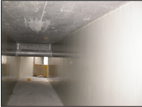
Abbildung 7: Epoxidharzbeschichtung Abbildung 8: Wanneneinbringung Zulauf ARA
