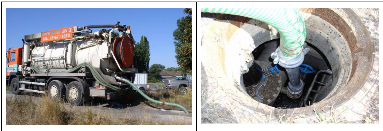
Abbildung 4: Leca Dosierung mit Kanalwagen in Sammler West RHV NSW
