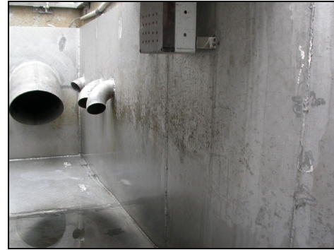
Abbildung 7: Epoxidharzbeschichtung Abbildung 8: Wanneneinbringung Zulauf ARA
