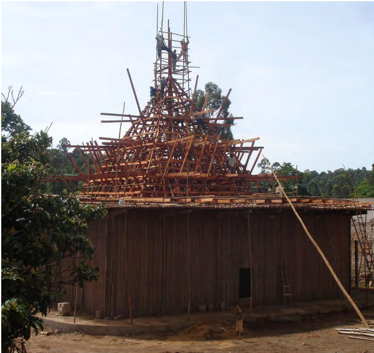
Abb.168: Die Errichtung des gewaltigen Dachstuhls für das "Große Haus" in *Bandjoun*. Hier wurde vor allem Hartholz verwendet.
