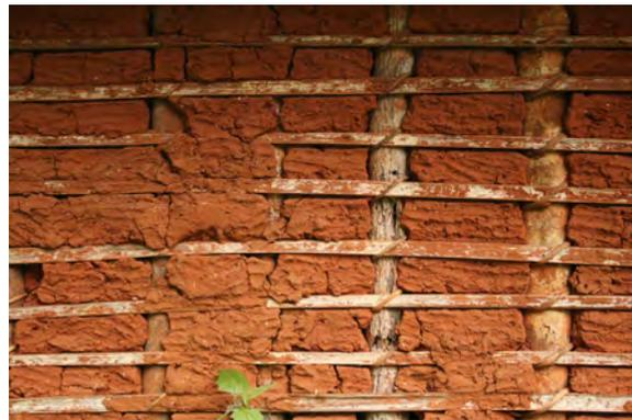
Abb.117: Hier sind die Schwindrisse deutlich sichtbar.
