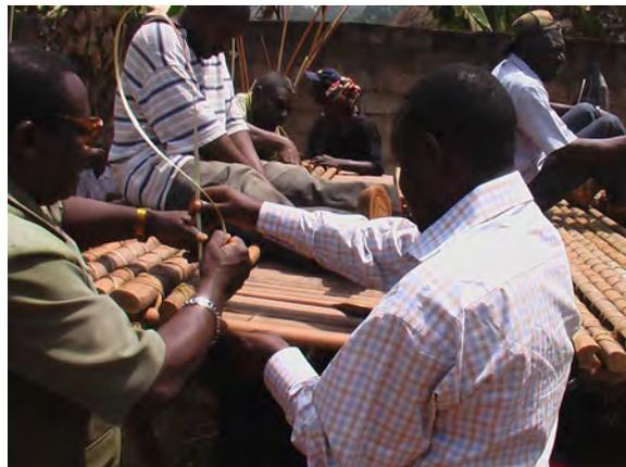
Abb.160: Männer beim Verbinden der einzelnen Mittelrippen für eine Wand.
