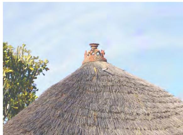
Abb.176: Keramischer Schutz für die Dachspitze.
