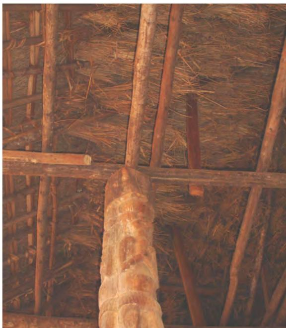
Abb.135: Deutlich sichtbare eingestrickte Grasbüschel.
