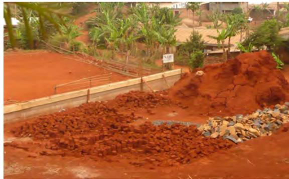
Abb.152: Ein aus Beton fertiggestelltes Streifenfundament.
