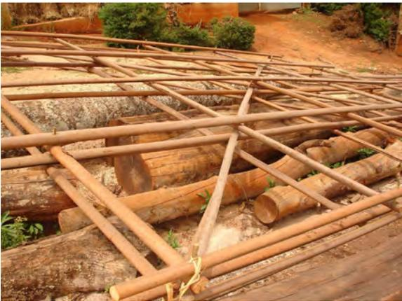
Abb.119: Vorgefertigte Rahmen mit Querverstrebung.
