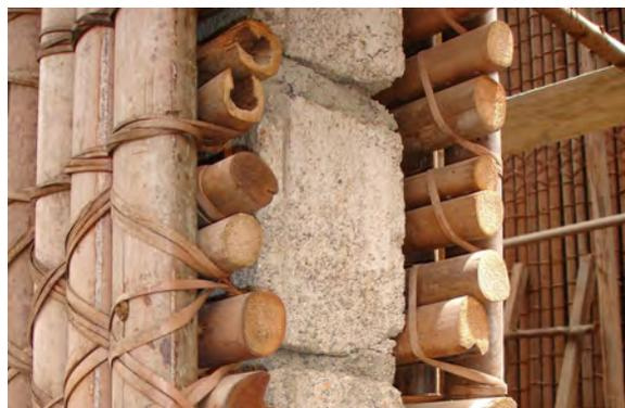
Abb.238: Die neue Wand des "Großen Hauses" in *Bandjoun*, wo die *Raffia*-Wandelemente nur zur Verkleidung der Betonsteinwand dienen.
