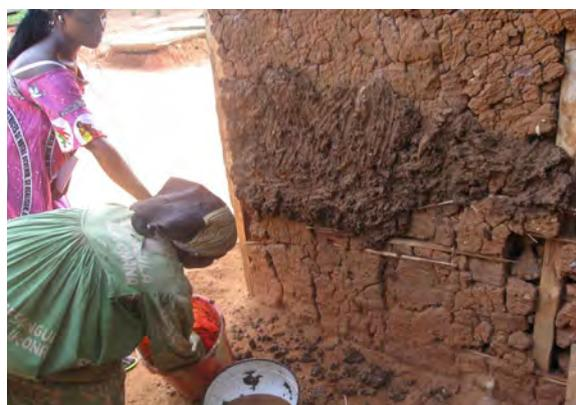
Abb.113: Die Wände müssen regelmäßig ausgebessert werden.
