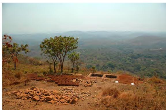
Abb.153: Das Streifenfundament mit den selbst hergestellten Lehmziegeln für die Wände.
