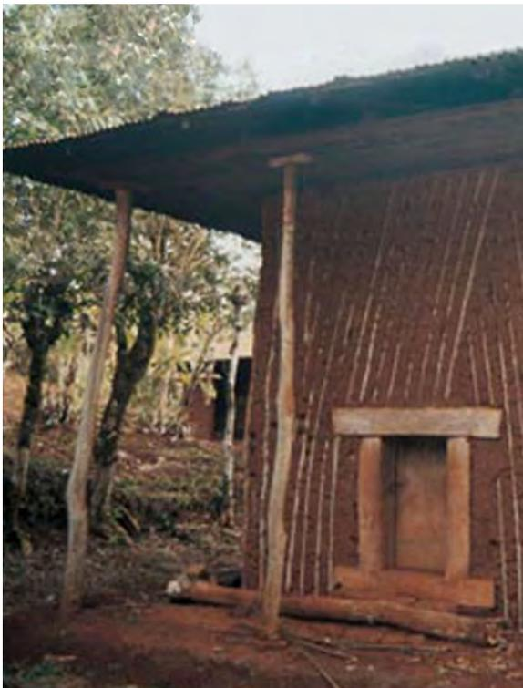
Abb.116: Die *Raffia*-Palmrippen bleiben auch nach der Ausfachung immer sichtbar und zeigen die leicht schräge Konstruktionsweise des *Raffia*-Palmen-Flechtwerks.
