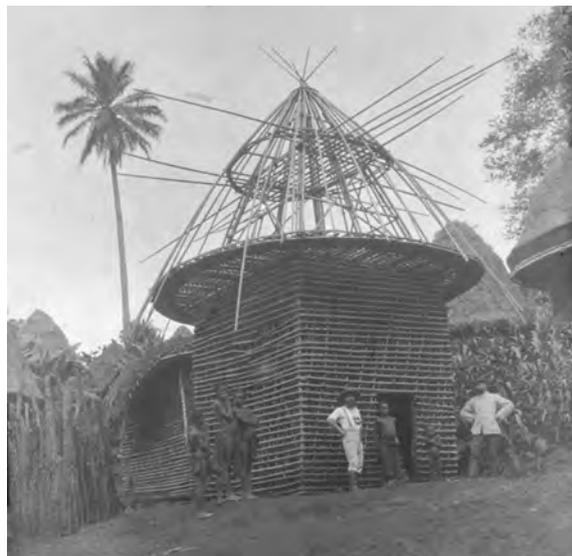
Abb.129: Der Dachstuhl mit dem oberen Plateau eines *Bayong* Hauses im Jahr 1914.
