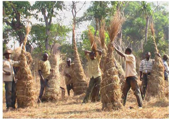
Abb.155: Gras zum Decken des Daches wird zum Transport in Bündel gebunden.
