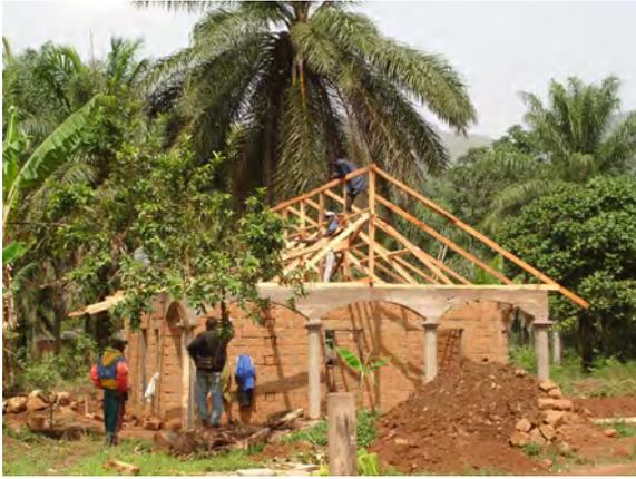
Abb.254: Moderner Hausbau aus Ziegeln, Beton und Bauholz.
