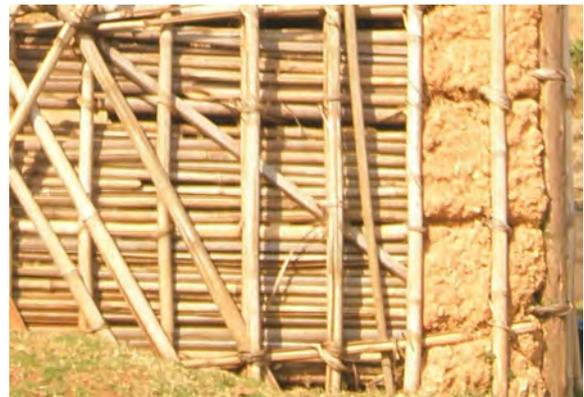
Abb.95: Detail vom Palast in *Oku*, der aus indigenem Bambus hergestellt wurde.
