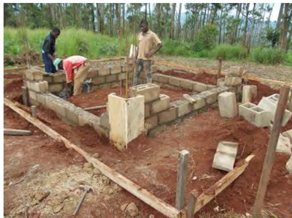
Abb.253: Neubau eines Hauses mit Betonhohlblockziegelsteinen.
