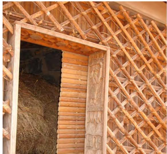
Abb.139: Schiebetür bei dem Torhaus in *Bamenda*, das zur trockenen Lagerung des Dachgrases genutzt wird.
