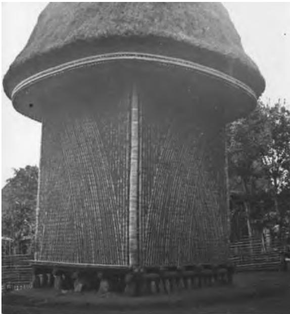
Abb.65: Bei Speichern wurde das Fundament immer ca. 50 cm über dem Erdboden erhoben.
