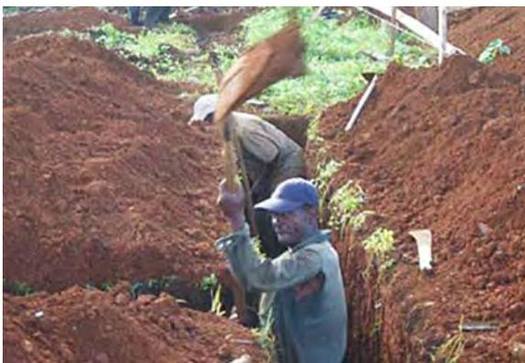
Abb.151: Männer beim Ausheben eines Fundamentgrabens.
