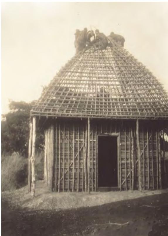
Abb.169: Männer bei der Fertigstellung der Dachkonstruktion.
