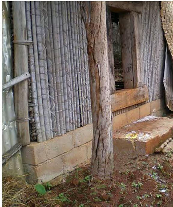
Abb.56: Eingangsbereich eines Frauen-Hauses in der *Chefferie Batoufam* mit einem Fundament aus gebrannten Ziegeln.
