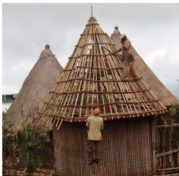
Abb.131: Dachkonstruktionen in gerader Kegelform.
