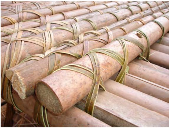
Abb.161: Vorgefertigter Wandteil für das neue "Große Haus" in *Bandjoun*.
