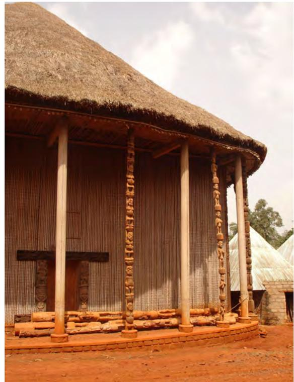
Abb.79: Das "Große Haus" der *Chefferie Bamenjinda* mit Pfosten teils aus Beton und teils aus Holz.
