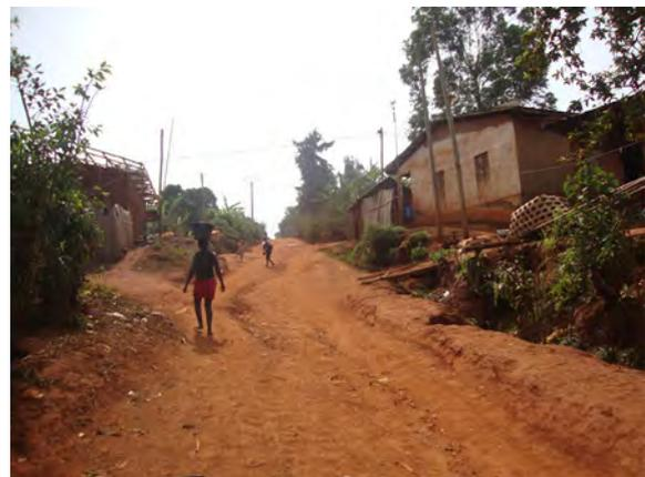
Abb.10: Eine steile Straße im Gebiet *Mbouda* mit tiefen Längsrillen, die bei Regen zu kleinen Bächen werden.
