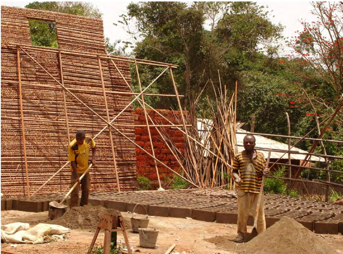
Abb.162: Männer bei der Vorfertigung der Lehmbausteine. Eine fertige Wand mit Türöffnung lehnt bereits im Hintergrund.
