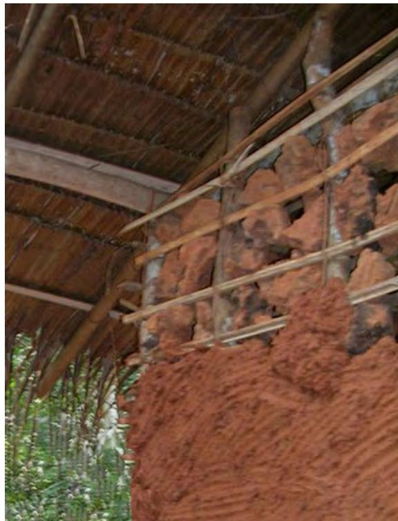
Abb.174: Hauswände werden mit einem Gemisch aus Wasser und Erde verputzt.
