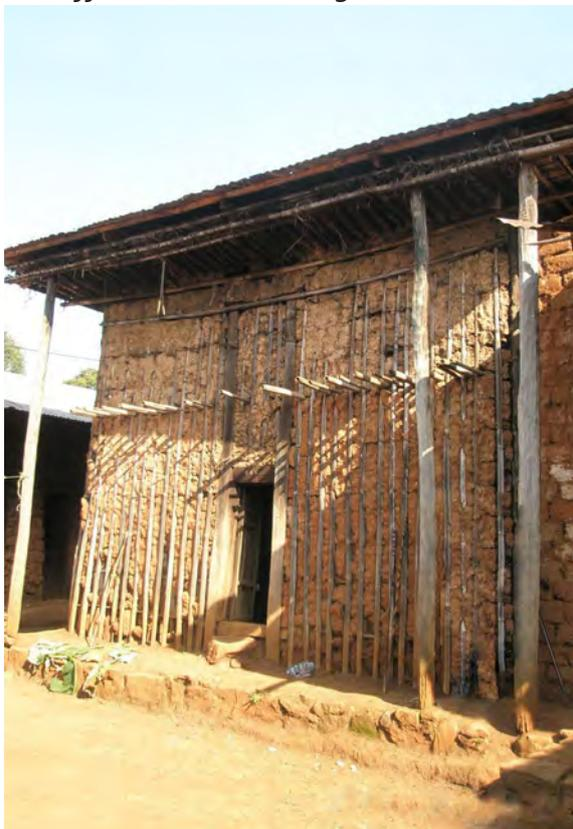
Abb.62: In der Region Oku (Bamenda) wird die Banda traditionell bis zur Fassade durchgezogen.
