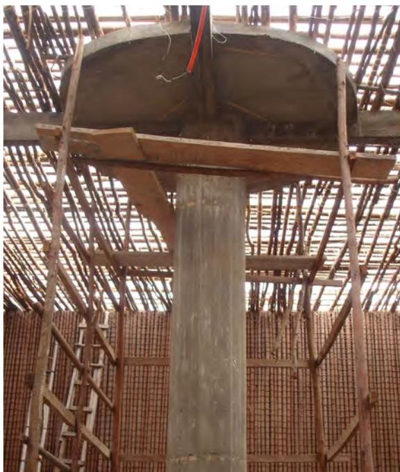
Abb.236: Bei der Rekonstruktion des "Großen Hauses" vertraute man die schwere Last des Daches lieber einem Betonpfeiler an.
