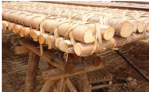
Abb.159: Die vorgefertigte Wandkonstruktion.
