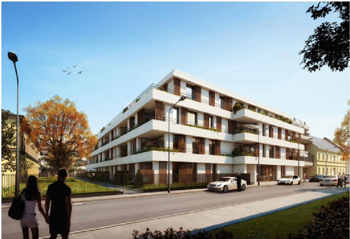
Abb. 22: Neubau in der Osterleitengasse.
