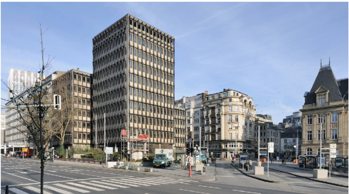
Abb. 26: Der abzubrechende Gebäudeblock.
