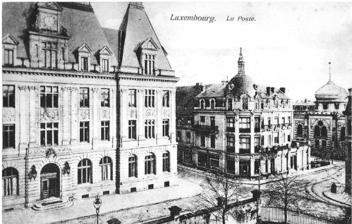
Abb. 24: Das Postgebäude in der Aldringerstraße.
