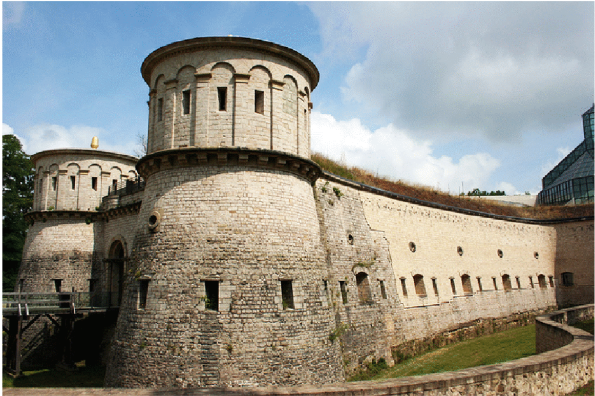
Abb. 5: Fugenband zwischen dem historischen und dem wiedererrichteten Mauerwerk.
