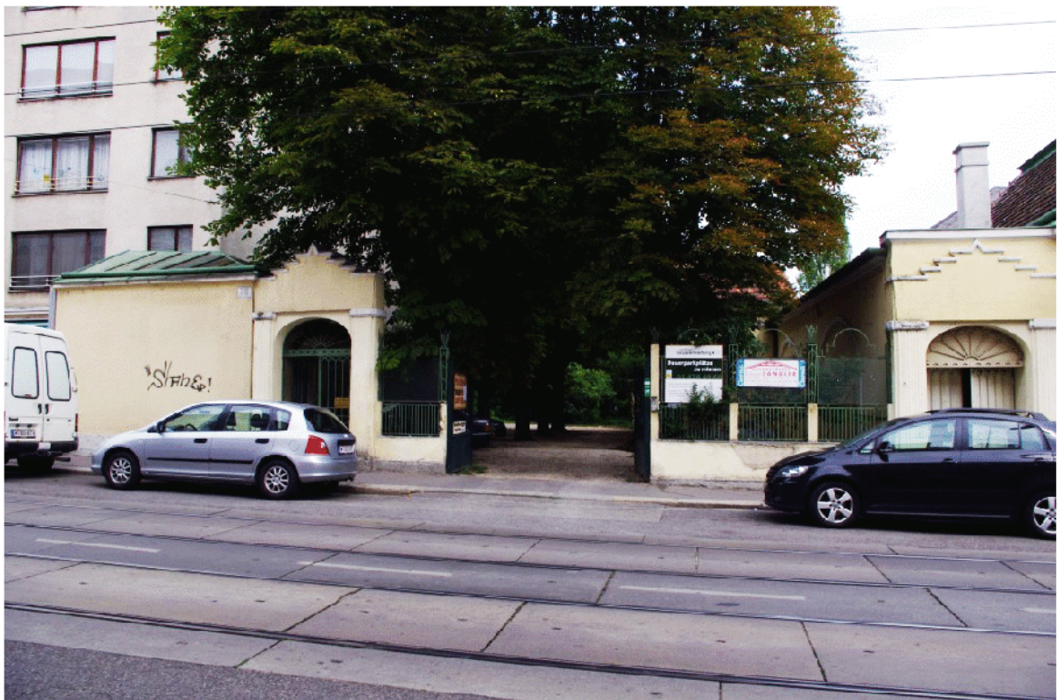
Abb. 20: Einfahrt auf den Parkplatz.
