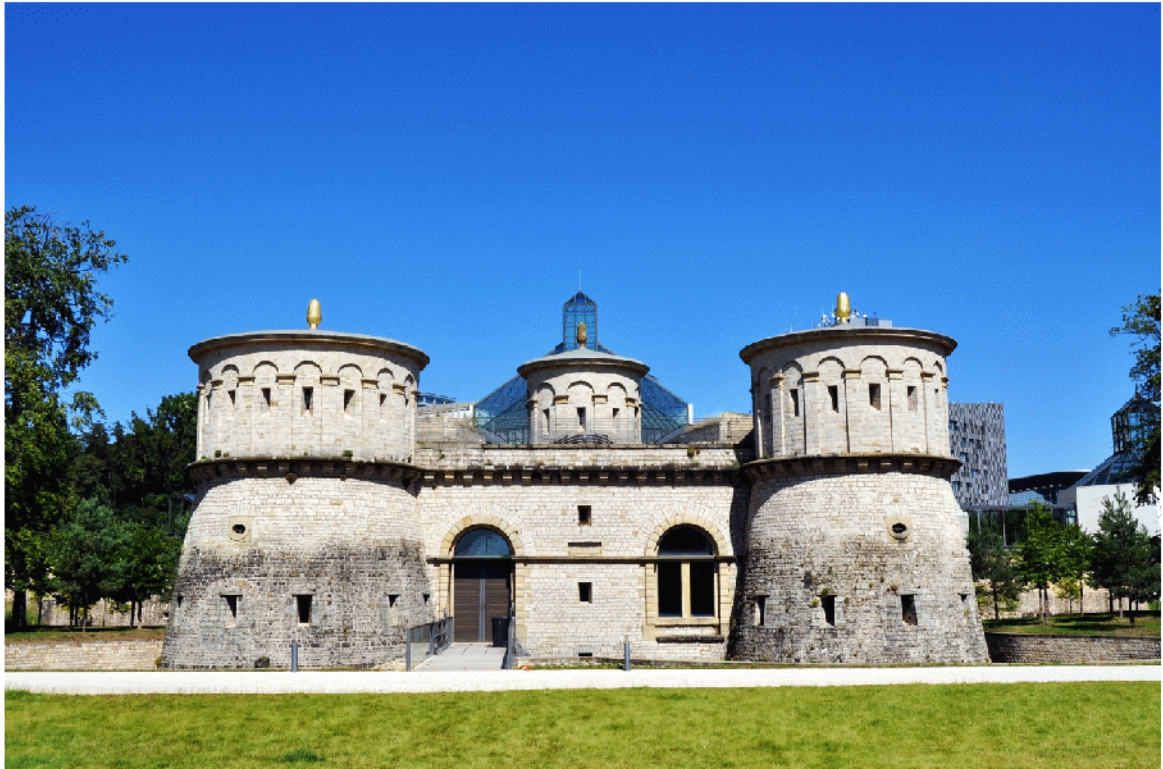
Abb. 7: Restaurierte Süd-West-Fassade des Forts Thüngen.
