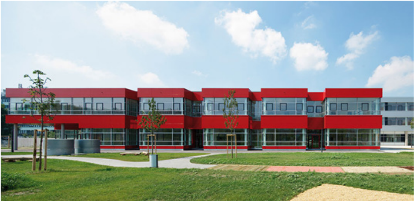
Abb. 31 Campus Gertrude-Fröhlich-Sandner, Nordbahnhof, Kaufmann.Wanas Architekten, PPP-Partner „PORR Solutions Immobilien- und Infrastrukturprojekte GmbH“ und “Bank Austria Real Invest GmbH”
