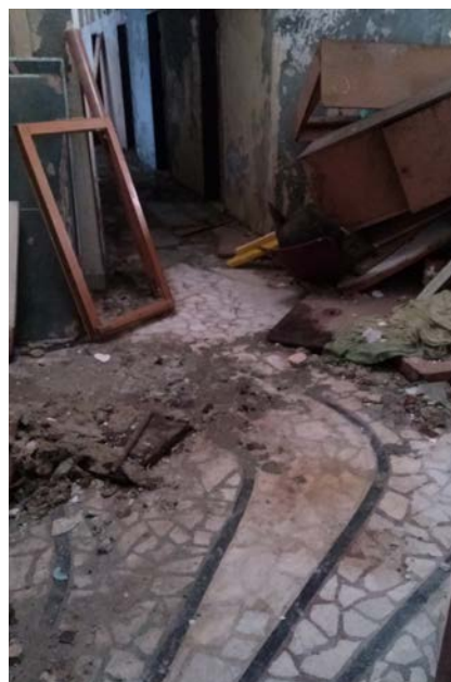
Abb. 84 Bodenbelag im Treppenhaus
