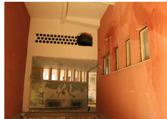
Abb. 92 Der Raum ist mit wasserdichtem Bodenbelag und rotem Außenputz versehen
