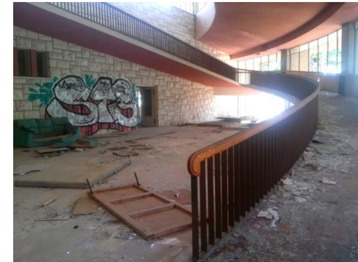
Abb. 145 Graffiti auf der Wand in der Halle des EG
