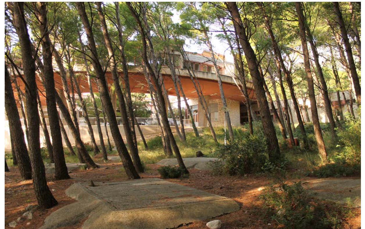
Abb. 44 Circa 20 Betonflächen befinden sich östlich vom Objekt im Wald verteilt
