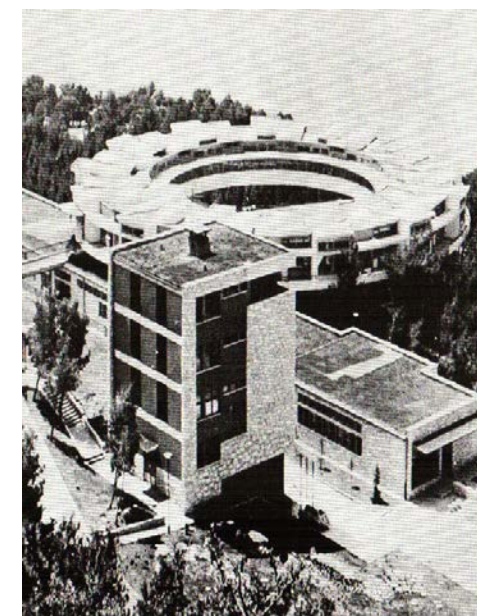
Abb. 32 Blick von Nordosten auf das Kinderhospital. Aus dem Referenzkatalog der ausführenden Firma Centroprojekt im Jahr 1975
