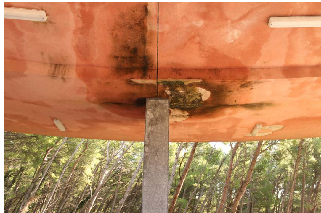
Abb.146 Wasserschaden an der Unterseite des Ringes
