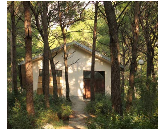
Abb. 43 Im Wald wurde ein Objekt mit Wäschräumen für die Campingbesucher eingerichtet
