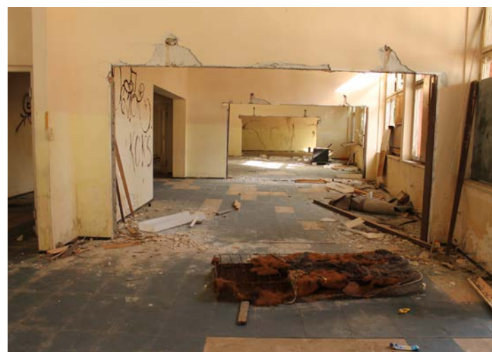
Abb. 57 Zugang zum TV-Saal Abb. 58 Vordere Glasfront mit Kastenfenstern und Schäden in den Wänden Abb. 59 Terrassentür die aus dem TV-Saal führt Abb. 60 Blick von außen auf TV-Saal und Gemeinschaftsräume
