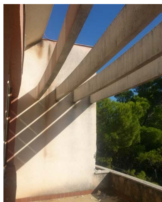
Abb. 129 Verschattungsvorrichtungen auf jedem Balkon verhindern Überhitzung
