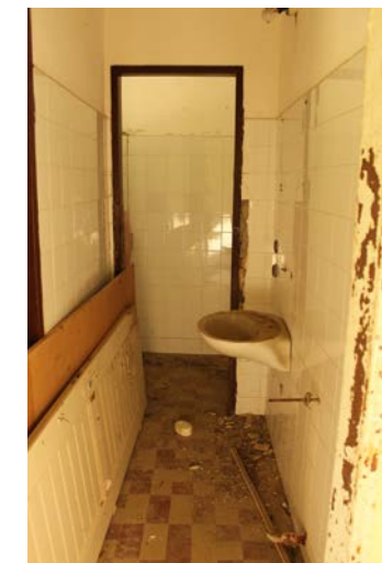
Abb.107 Nassraum bei Zimmer 22
