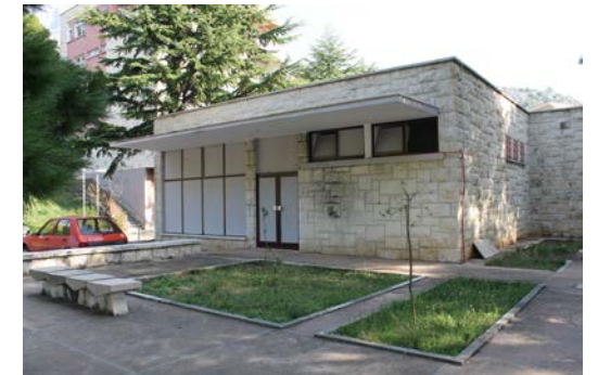
Abb. 105 Ehemaliger Eingangsbereich und Toiletten von Außen
