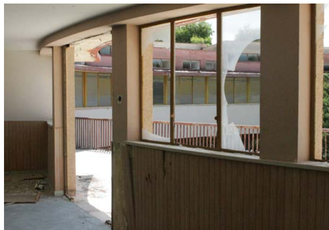
Abb. 118 Zugang zur Terrasse
