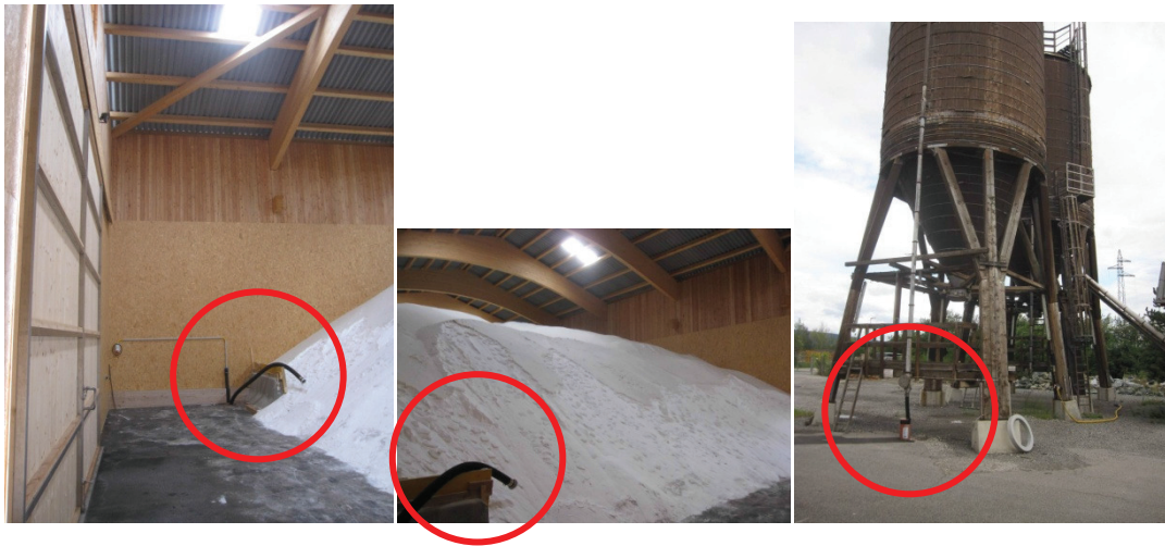
Abb. 12: Ansaugschlauch in der Lagerhalle und Ablassschlauch beim Silo
