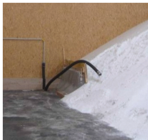
Abb. 36: Ansaugschlauch für pneumatische Befüllung
