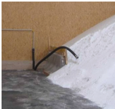
Abb. 36: Ansaugschlauch für pneumatische Befüllung
