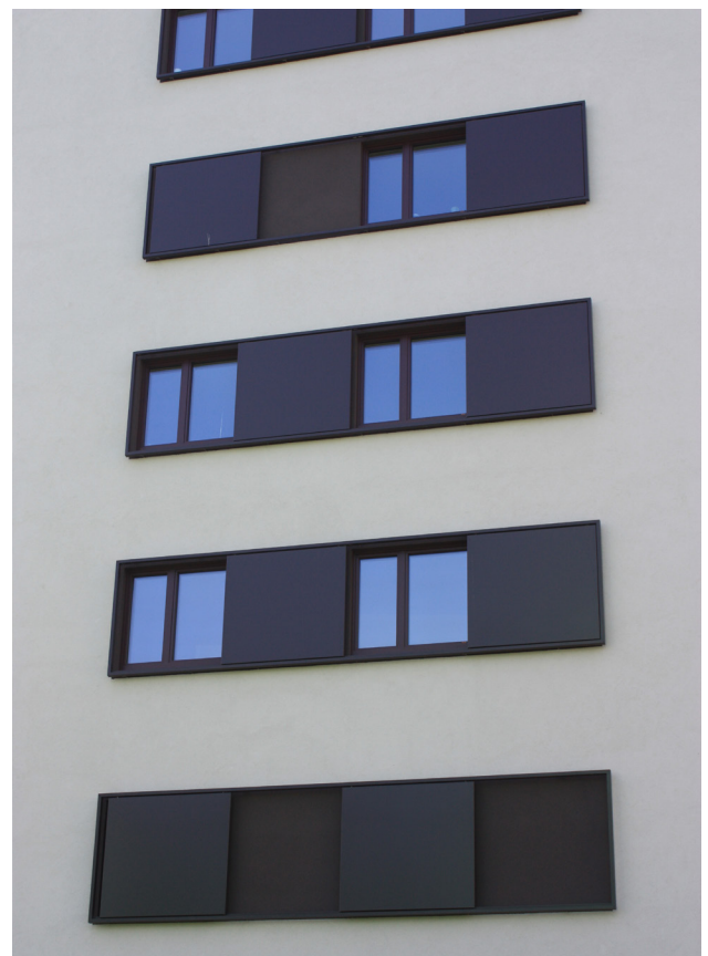
Abbildung IV-33: opaker Sonnenschutz des Außenfensters
