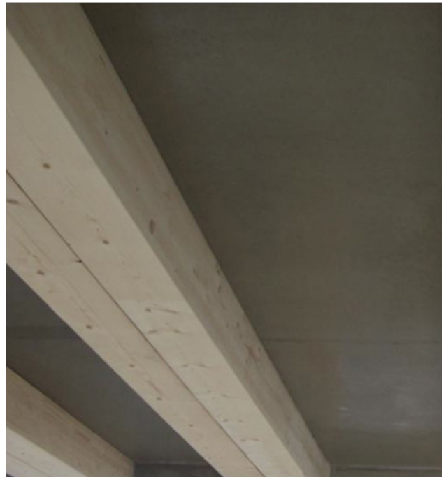
Abbildung III-9: Holz-Beton-Verbunddecke (60)
