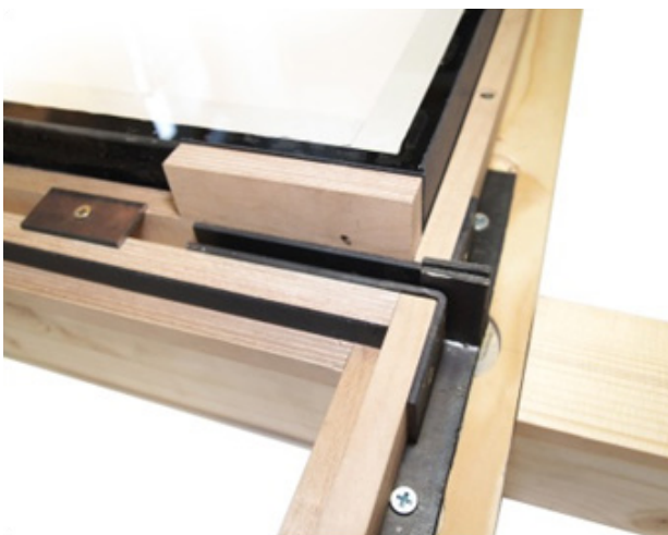
Abbildung III-6: Konstruktionsbeispiel Holz-Glas-Verbund (55)
