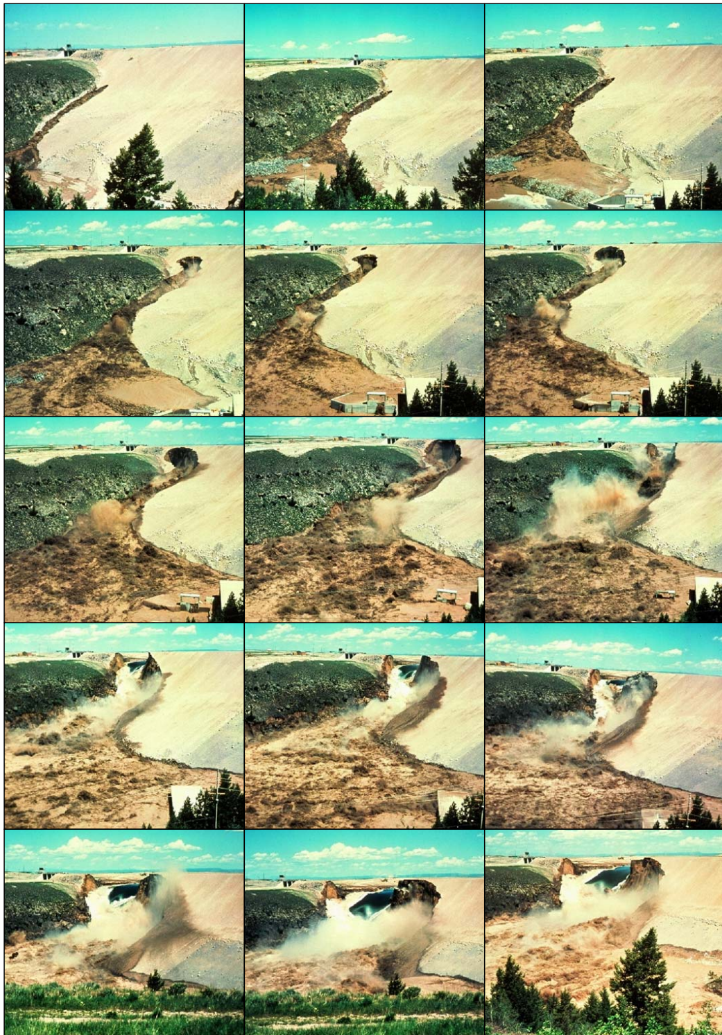
Abbildung 2.9: Versagen des Teton Dammes in Idaho im Juni 1976, Fotos von Eunice Olson, http://www.geol.ucsb.edu/faculty/sylvester/Teton_Dam/TetonDam.html (abgerufen am 14.5.2014)
