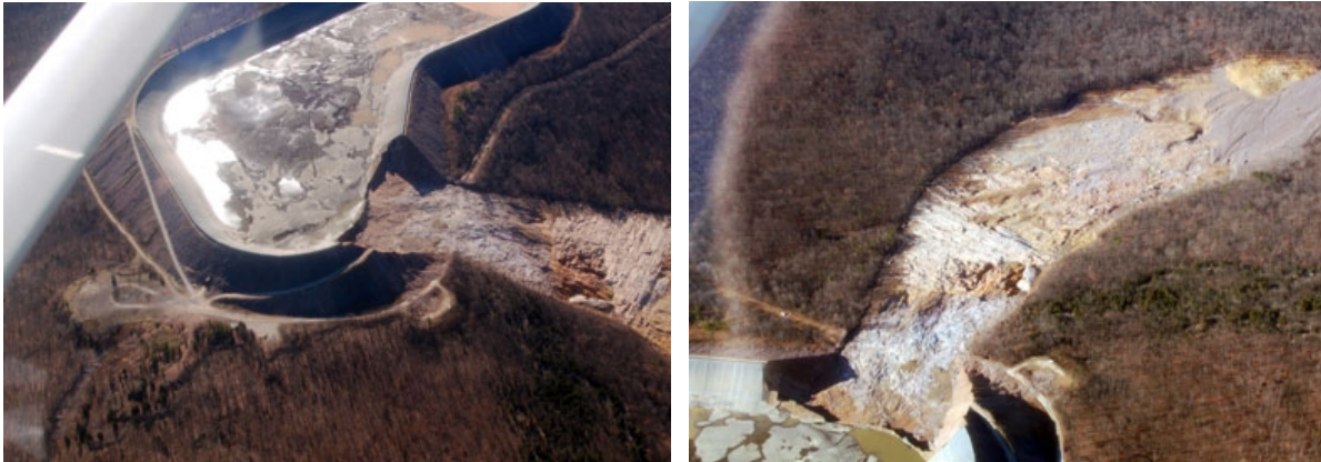
Abbildung 2.12: Bruch des Oberbeckens des Pumpspeicherkraftwerks Taum Sauk 2005 Quelle: U.S. Geological Survey
