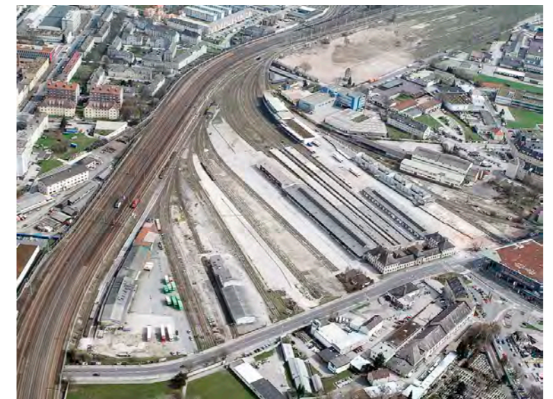
Abb. 40 Frachtenbahnhof vor dem Abbruch
