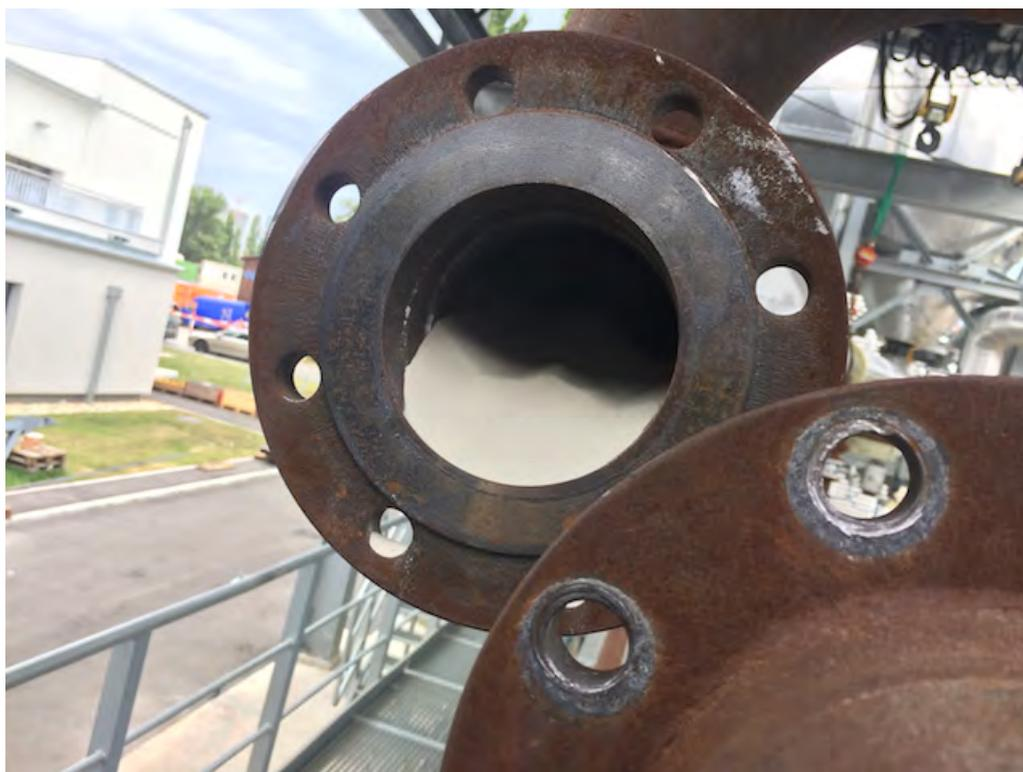
Abbildung 7.2.: Verstopfte Rohrleitung durch mitgeführten Sand.
