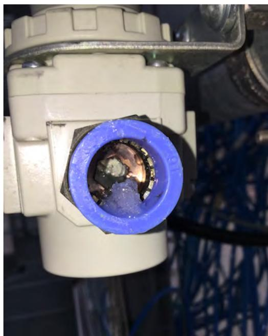
Abbildung 7.1.: Gefrorenes Wasser im Druckreduzierer der Prozessluft.
