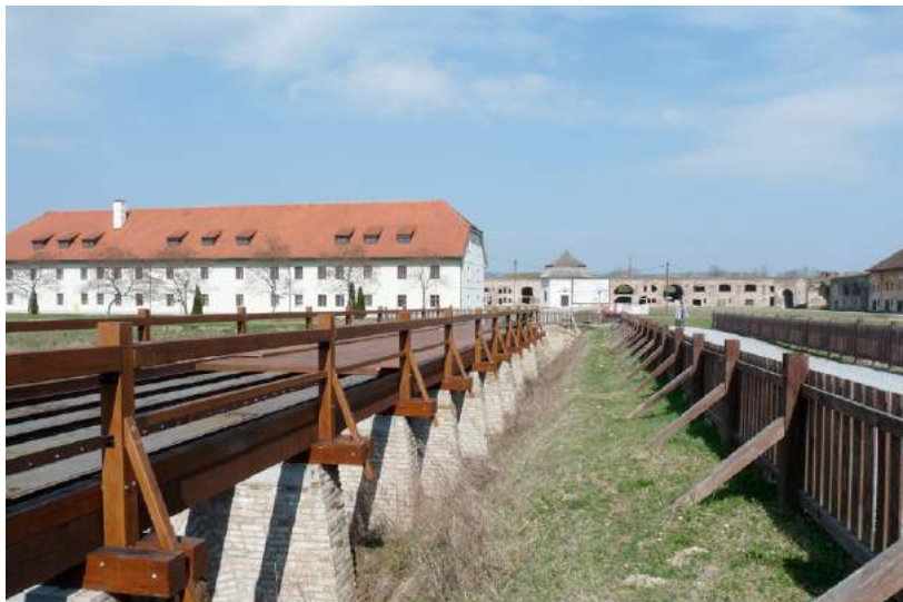
Abb. 40: Brücke kurz vor der Fertigstellung, 15-03-2017
