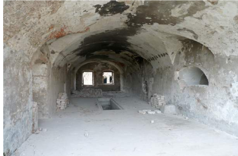
Abb. 47: Innenraum im Nordkavalier, 15-03-2017
