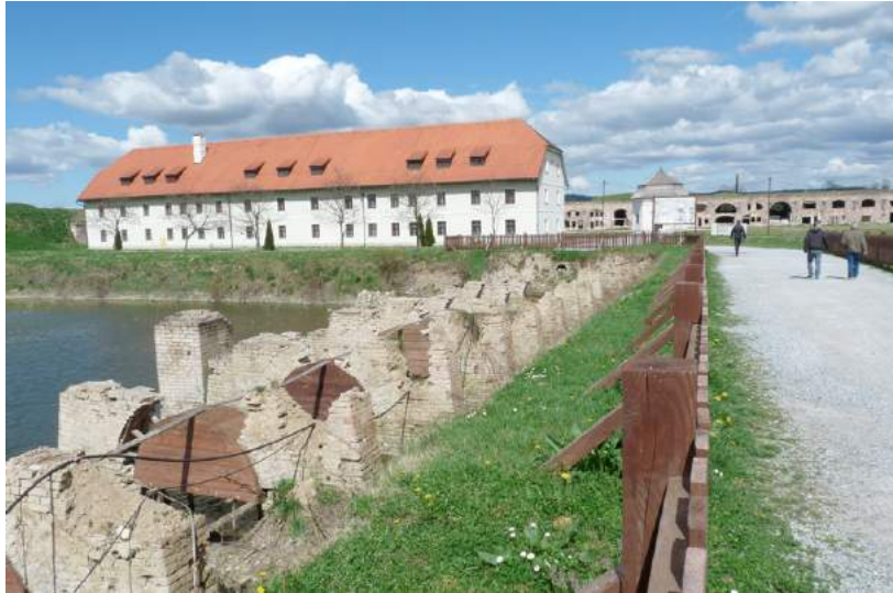
Abb. 38: Brücke während der Wiederherstellung, 03-04-2015
