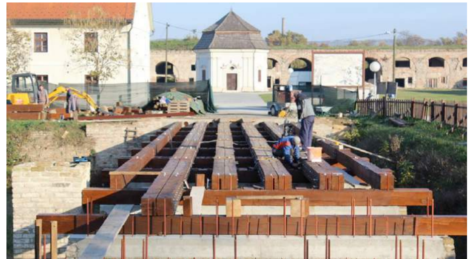
Abb. 32: Wiederherstellung der Holzbrücke; im Hintergrund die fertig gestellte Kapelle, 2016
