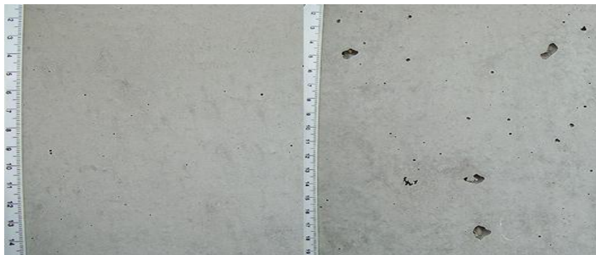
Abbildung 2-19: linke Bildseite: schalungsseitige Betonoberfläche mit ENTLÜFTER, rechts ohne[2-20]
