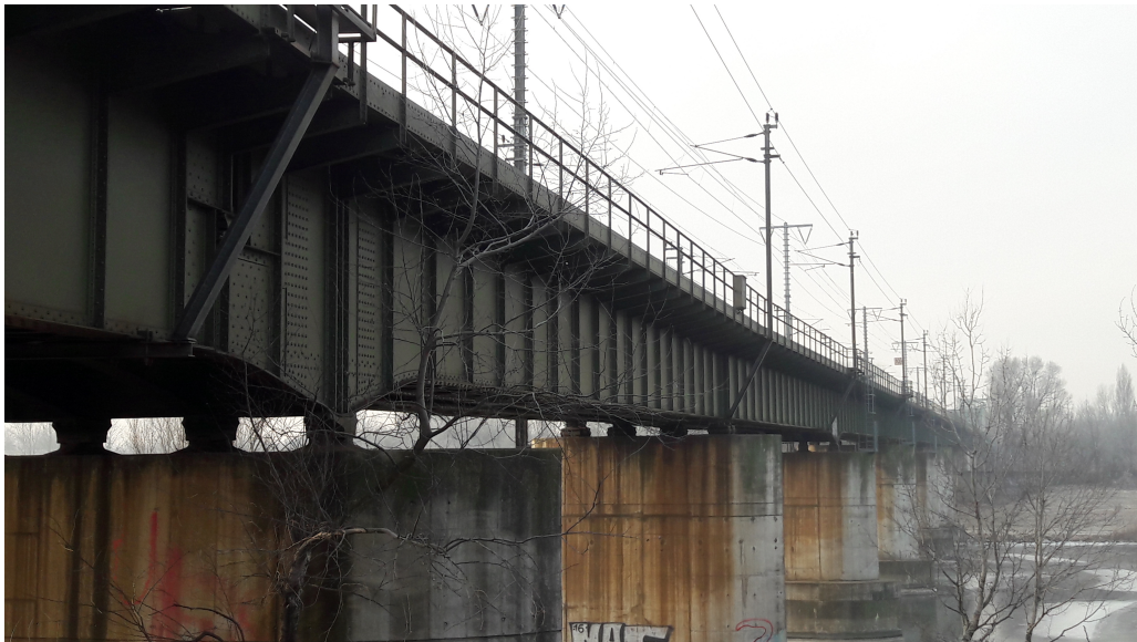
Abb. 3.1: Ansicht der Ostbahnbrücke; Abschnitt mit Vollwandträgerbrücke.
