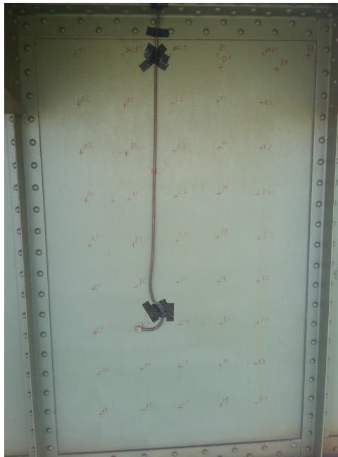
Abb. 5.26: Ansicht des Stegblechs der Ostbahnbrücke: Einteilung des Messfeldes in ein Raster für EMA.
