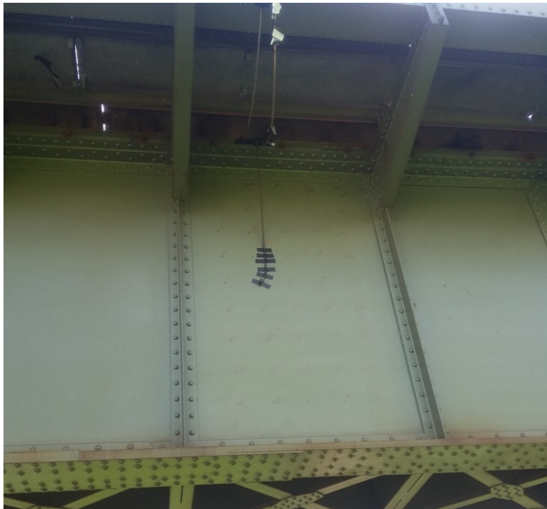
Abb. 3.4: Ansicht der Ostbahnbrücke mit Beschleunigungssensor. Bild aus [9].
