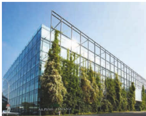
Abbildung 9 - Bodengebundene Begrünung, Gerüst
