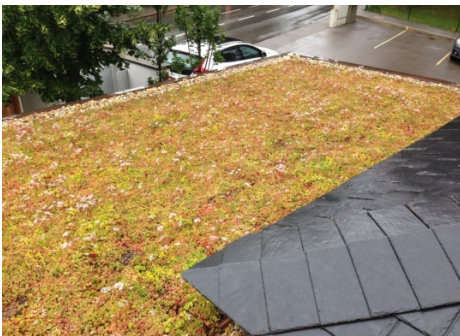
Abbildung 19 - extensive Dachbegrünung
