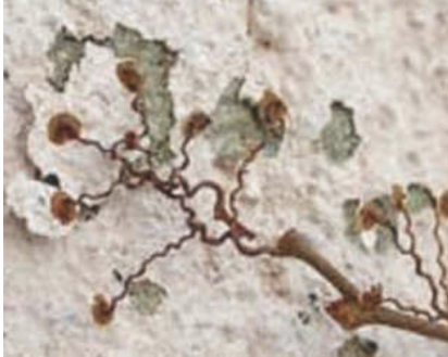
Abbildung 15 - Haftorgane lösen sich von Fassade
