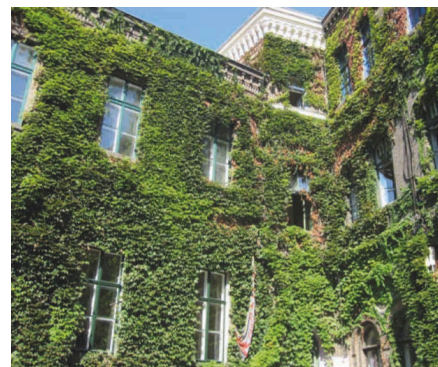
Abbildung 10 - Bodengebundene Begrünung, direktbewuchs
