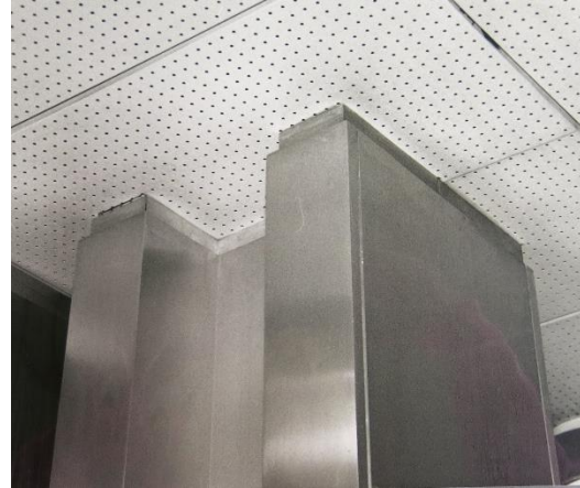
Abb. 97: Edelstahlverkleidete Stützen mit abgehängter Lochblechdecke, Hauptanstalt Wien 3, Artur Perotti, 1965
