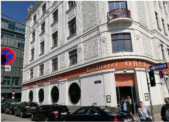
Abb. 159: ehemalige Zweigstelle Vordere Zollamtstraße, Wilhelm Holzbauer, 1973
