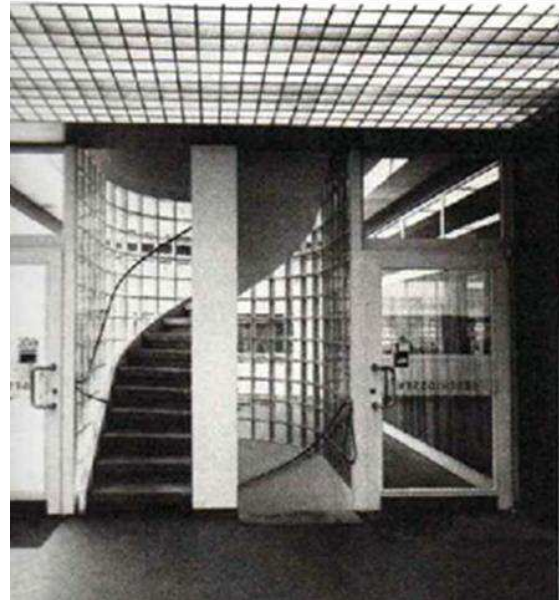
Abb. 52: Eingangssituation innen mit Wendeltreppe, Reinprechtsdorfer Straße, Kurrent/Spalt, 1970
