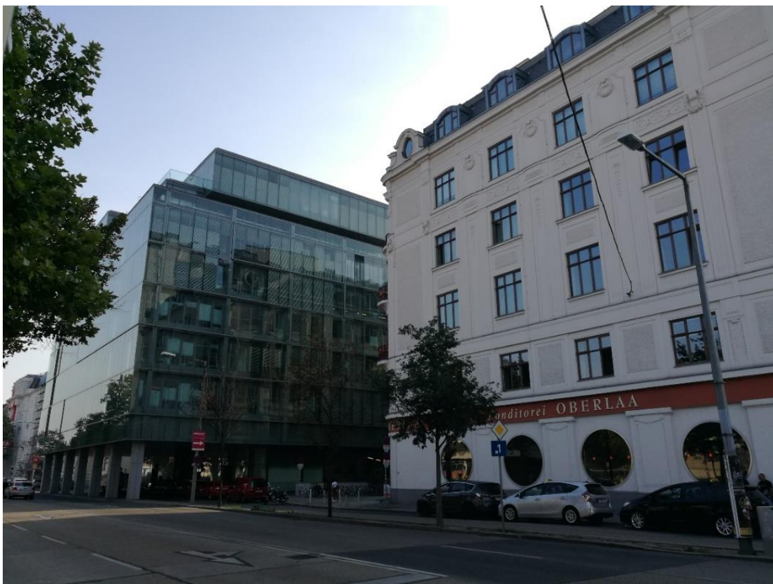
Abb. 109: Heute: Kundenzentrum der Bank Austria Wien 3., Vordere Zollamtsstraße 13. Im Vordergrund: ehemalige „Z“-Filiale Landstraßer Hauptstraße 1, Wilhelm Holzbauer, 1973 (2019)
