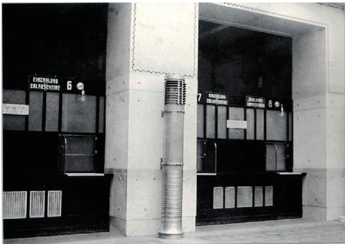
Abb. 130: Postsparkasse, Kassenschalter in den Pfeilernischen, vergittert und verglast, Otto Wagner, 1906
