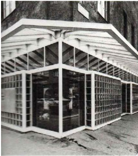
Abb. 51: Ecklösung Glasfelder und korbartig auskragende Glasbausteinfelder, Reinprechtsdorfer Straße, Kurrent/Spalt, 1970
