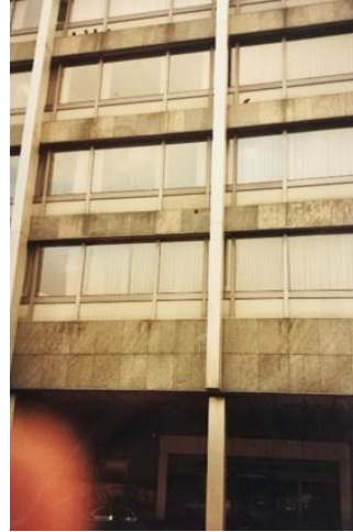
Abb. 92: Steinplattenverkleidung der Fassade, Artur Perotti, 1967
