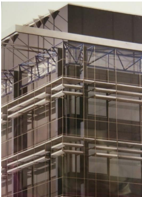
Abb. 107: Beschattungssystem, Kundenzentrum Wien Mitte, Günther Domenig, 1987
