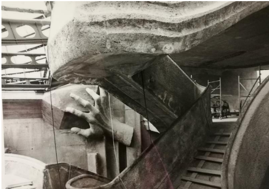
Abb. 75: „Die Hand“ und Brüstungen in der Rohbauphase, Zweigstelle Favoriten, Günther Domenig, 1979
