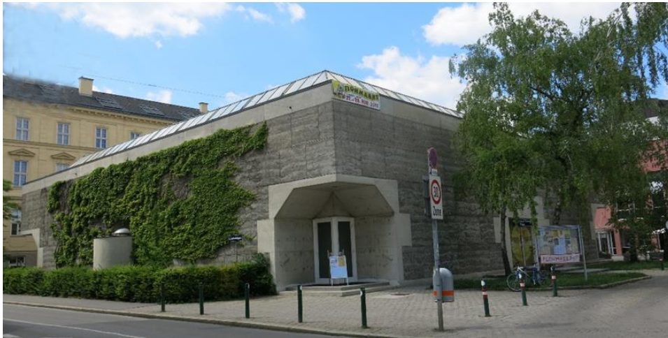
Abb. 164: Konzilsgedächtniskirche Lainz nach der Generalsanierung, Josef Lackner, 1965 (2017)
