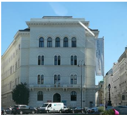
Abb. 1: Die ehemalige Hauptzentrale der Bodencreditanstalt, Emil Förster, 1885 (2019)
