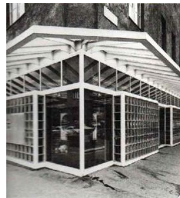
Abb. 153: Vordach der Zweigstelle Reinprechtsdorfer Straße, Kurrent und Spalt, 1971
