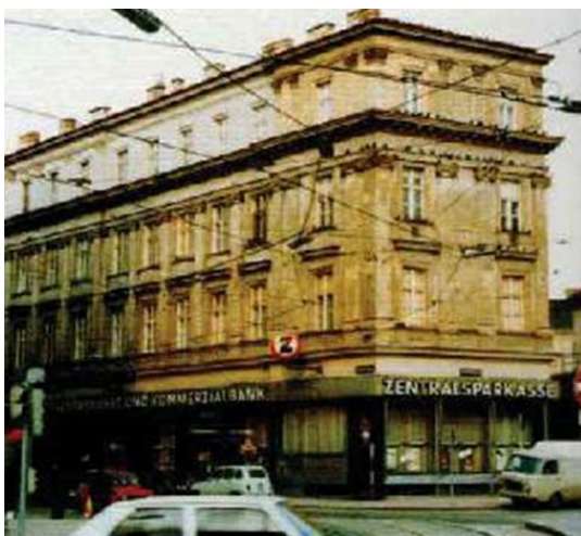
Abb. 57: Zweigstelle Radetzkyplatz vor dem Umbau, Hans Hohenegger, 1961
