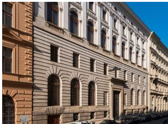
Abb. 2: Die ehemalige Länderbank, Wien 1, Hohenstaufengasse, Otto Wagner, 1883 (2015)
