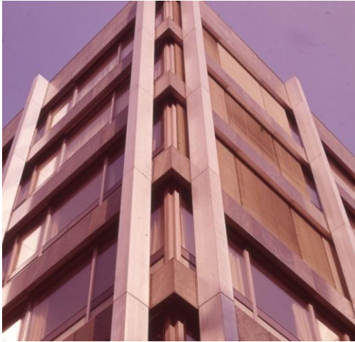
Abb. 91: Fassade zur Vorderen Zollamtstrasse, Stahlbetonskelett, Artur Perotti, 1967
