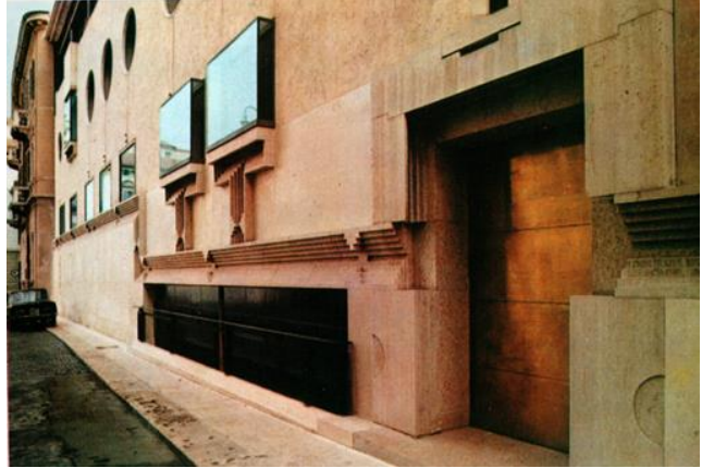
Abb. 141: Messing- und eisengepanzertes Eingangportal in geschlossenem Zustand
