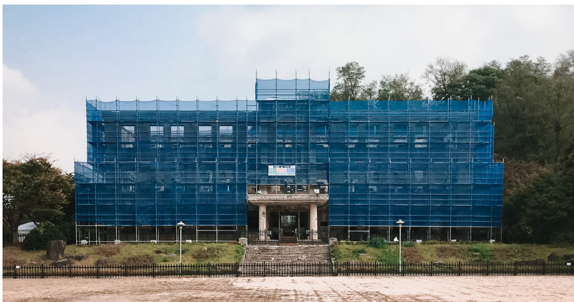
Abb.33: Reparatur- und Verstärkungsarbeiten, von September bis Dezember 2020
