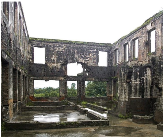
Abb.65: Blick in den Raum 1.OG_07
