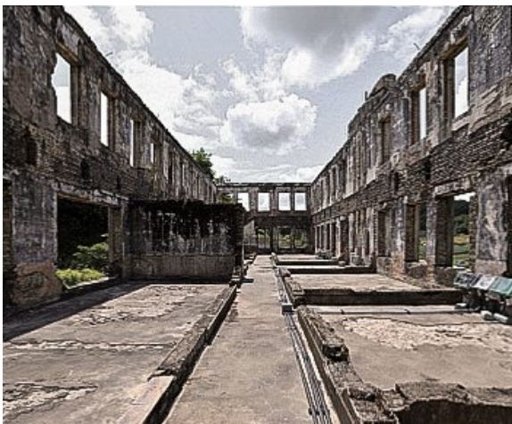
Abb.61: Blick nach Süden
