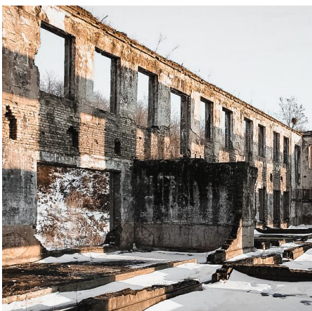
Abb.54: Blick in den Raum 1.OG_02
