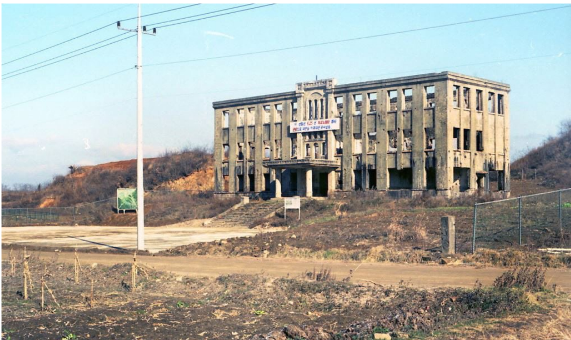
Abb.23: Vorder-Seitenansicht vor der Instandhaltung, 1973
