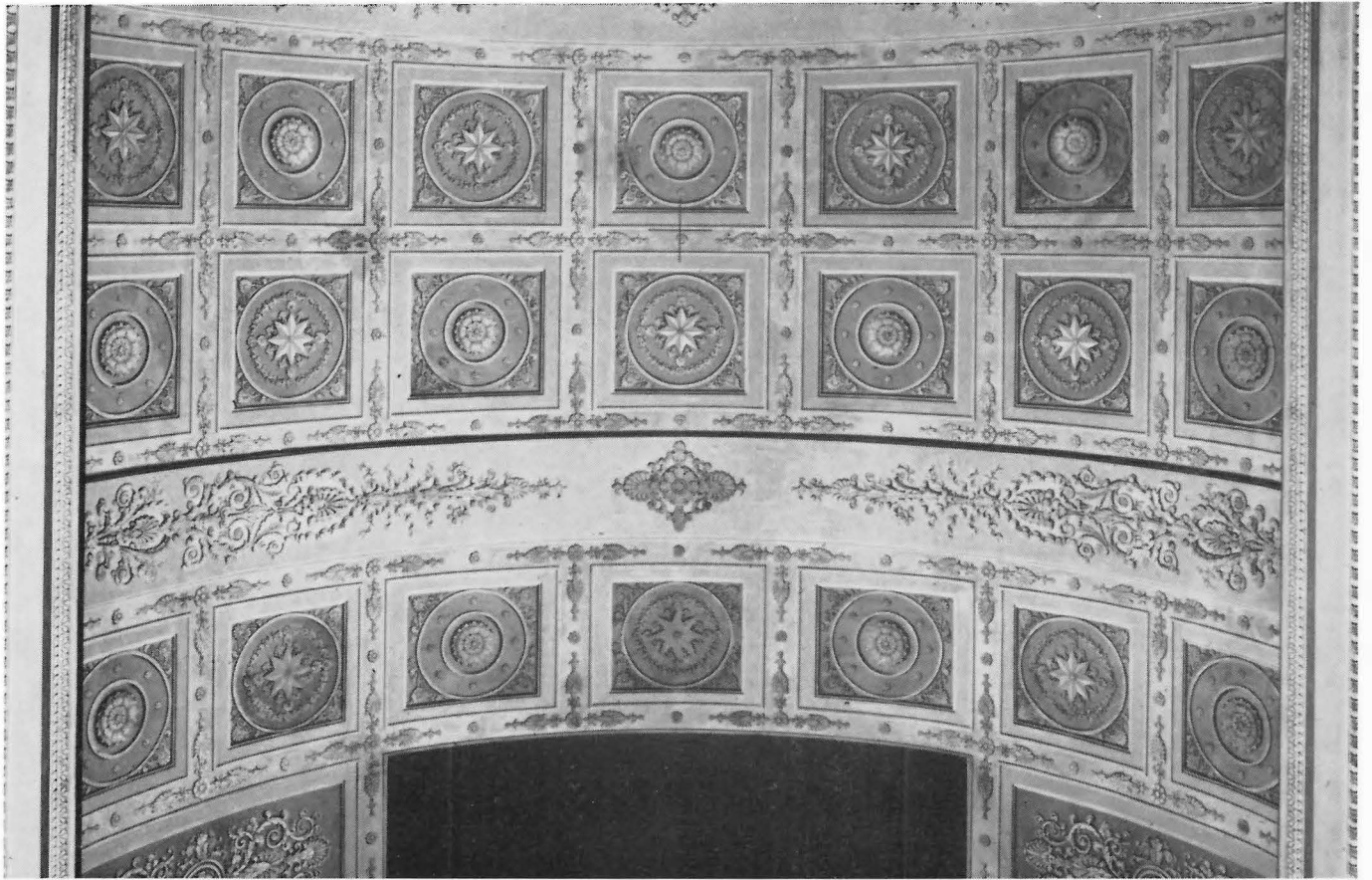
Bild 1: Ausschnitt aus einer um den Faktor 2,1 vergrößerten Zenitaufnahme des Bibliotheksaales des Wiener Schotten-Stiftes (Aufnahmekamera: Wild P 31, Kammerkonstante: 99,13 mm, Aufnahmeentfernung bis zum Scheitel des Tonnengewölbes: 11,80 m).
