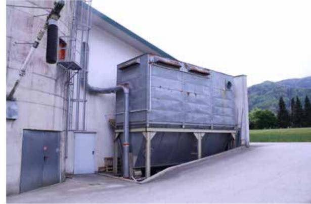
Abb.117 Entstaubungsanlage im Außenbereich
