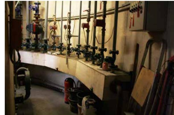
Abb.115 Heizraum - Heizungsverteiler
