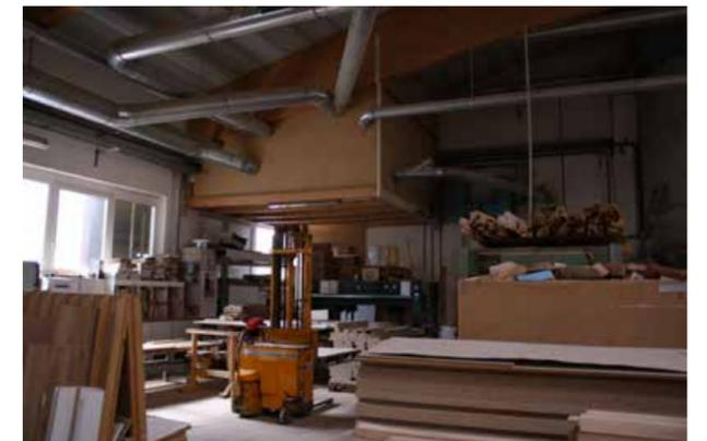
Abb.87 Leitungsführung Entstaubungsanlage
