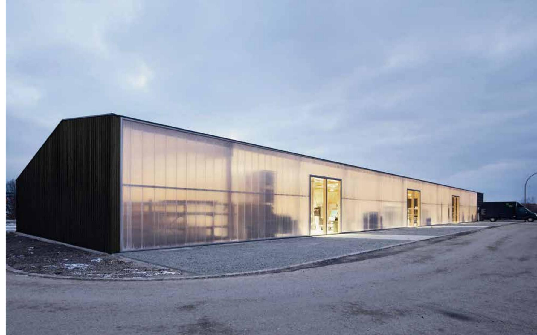
Abb.8 Perspektive Lieferbereich mit transluzenter Fassade aus Polycarbonat
