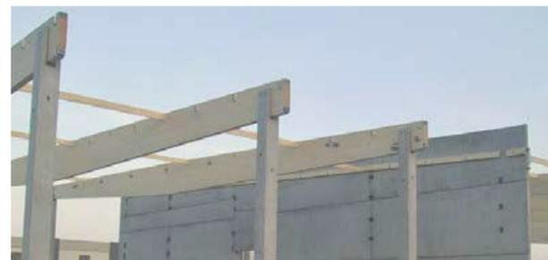
Abb.210 Beispiel Knoten Betonstütze Holzträger
