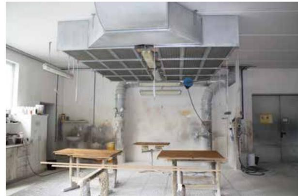
Abb.118 Lackierraum - Feinstaubabsaugung
