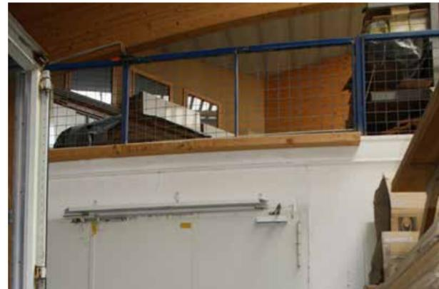
Abb.92 Brandschutztür zur Maschinenhalle und Obergeschoß
