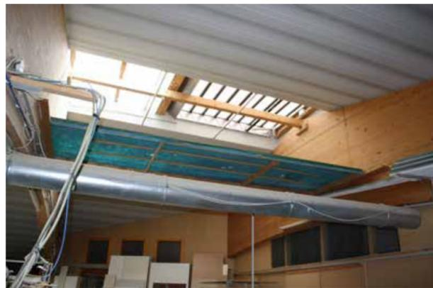
Abb.101 Oberlicht / Brandrauchentlüftung
