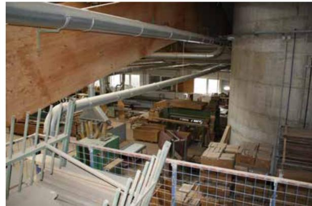
Abb.103 Maschinenhalle - Leitungsführung Absaugungsanlage
