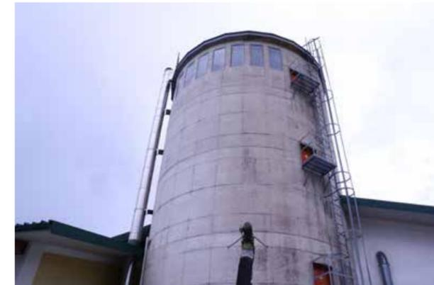
Abb.71 Silo mit Aufstiegsleiter, Einstiegsluken und Explosionsklappen
