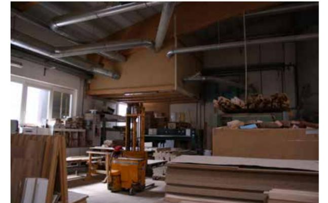
Abb.116 Entstaubungsanlage im Innenbereich - Leitungsführung
